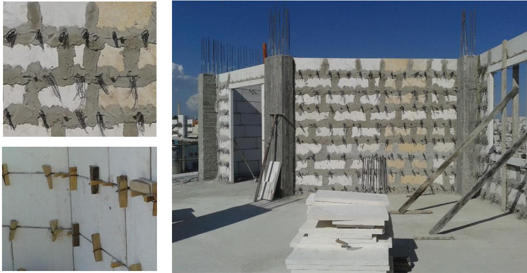
الشكل 3:5 طريقة البناء في مدينة الخليل
