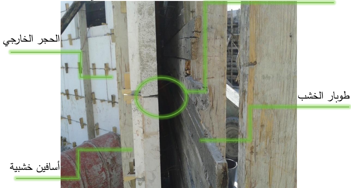
الشكل 3:6 طريقة تثبيت الطوبار الخشبي بالحجر الخارجي باستخدام القطع الخشبية
