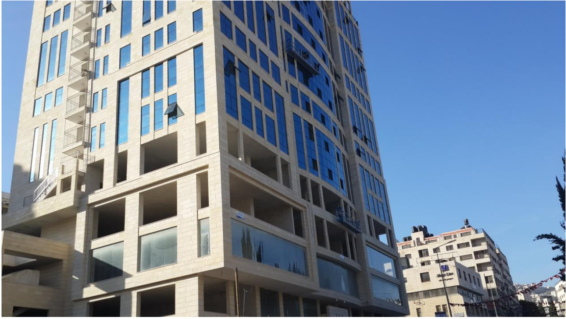
صورة رقم 32: توضح الشكل الخارجي للمبنى.
