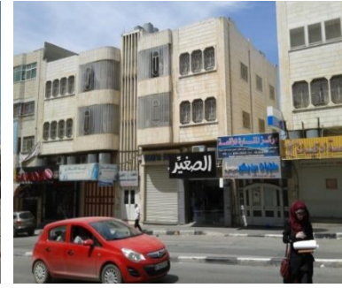
صورة (4) : مبنى سكني وتجاري
