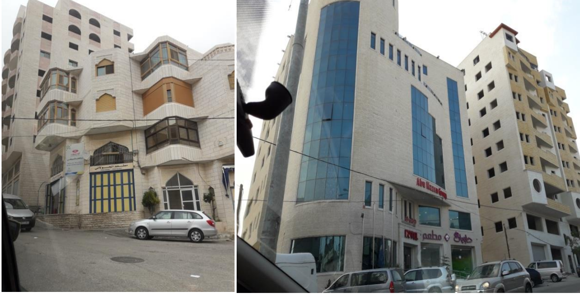
الشكل (4-20) : صورتان لعدم التماثل الأفقي والرأسي في مباني من المنطقة الثانية (المصدر : الباحثة)
