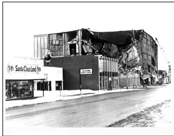
الشكل (3-10): صور انهيار في مبنيين متجاورين - زلزال ألاسكا 1964
