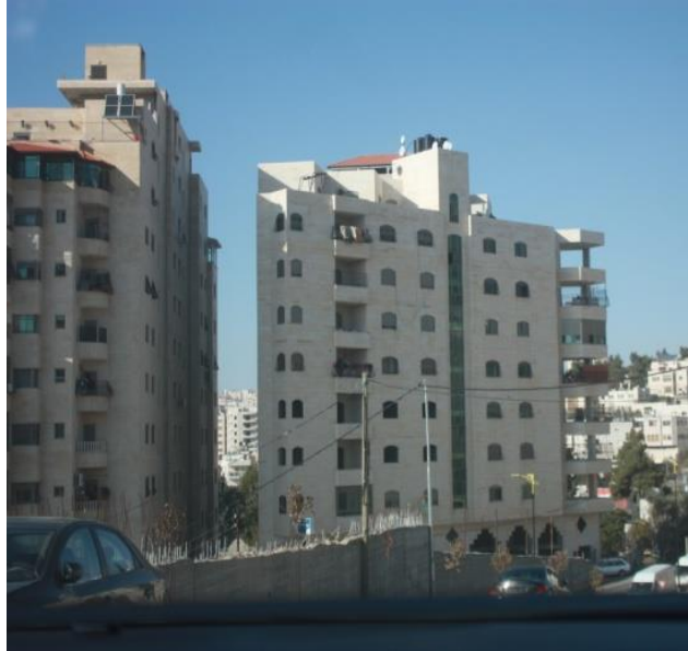
الصورة (3-4): مباني مكونة من 11 طابق في مدينة الخليل (المصدر : الباحثة)
