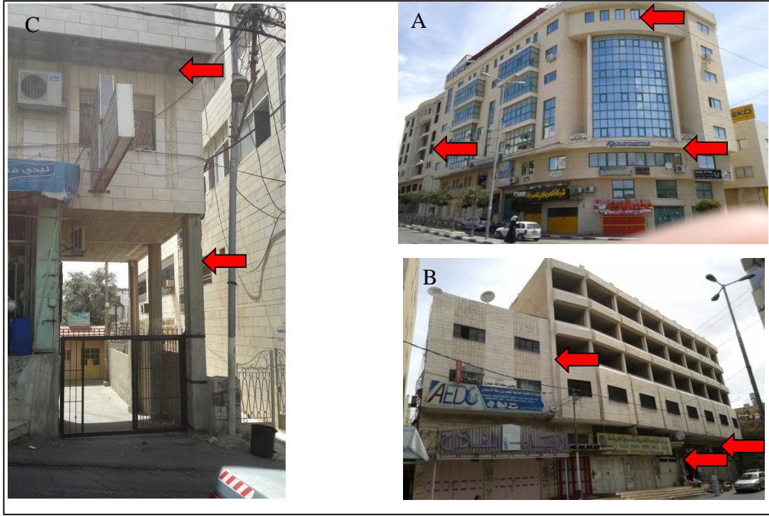
الشكل (4-14): استخدام طيرانات وطابق رخو وعدم تماثل افقي وعمودي وعدم وجود فواصل (المصدر : الباحثة)
