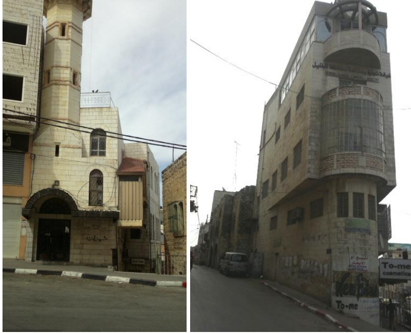
الشكل (4-23) : صورتان لمبنيين نحيفين في المنطقة الاولى المصدر : الباحثة
