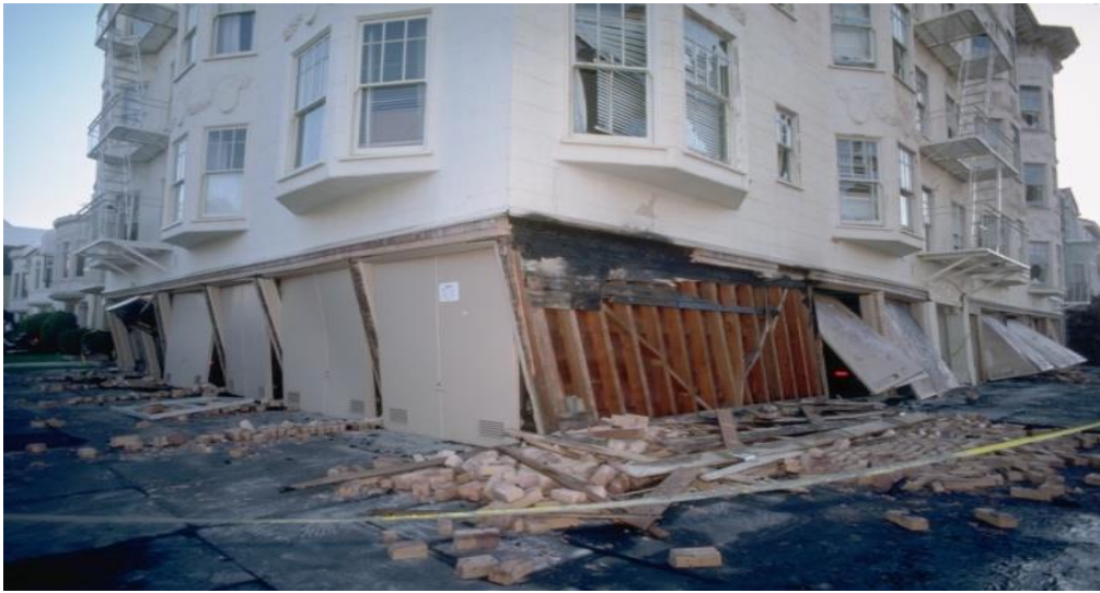
الصورة (3-5) : انهيار جزئي بسبب تشكيل الطابق الرخو (زلزال لوما بريتا- الولايات المتحدة 1989 المصدر : https://pubs.usgs.gov/dds/dds-29/screens/007sr.jpeg
