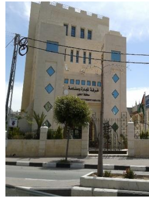
صورة (7) : مبنى الغرفة التجارية
