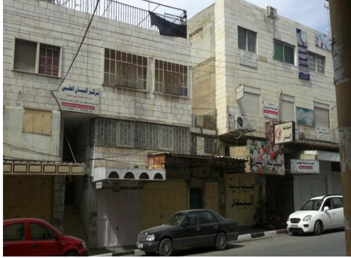
الصورة (4-6) : أعمدة قصيرة وطيرانات (المصدر : الباحثة)
