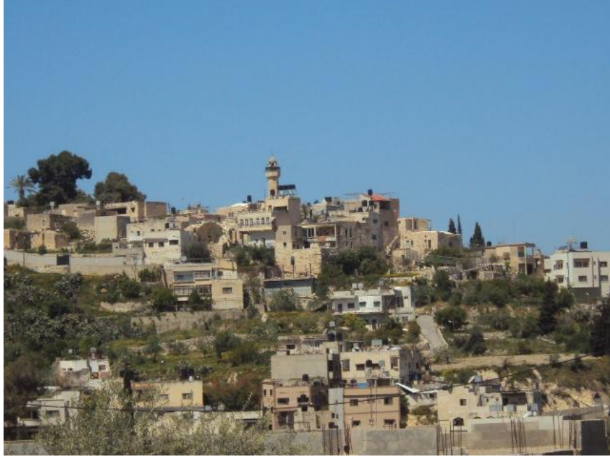
شكل (1-1) المباني القديمة في قرية سبسطية (أريج، 2014)
