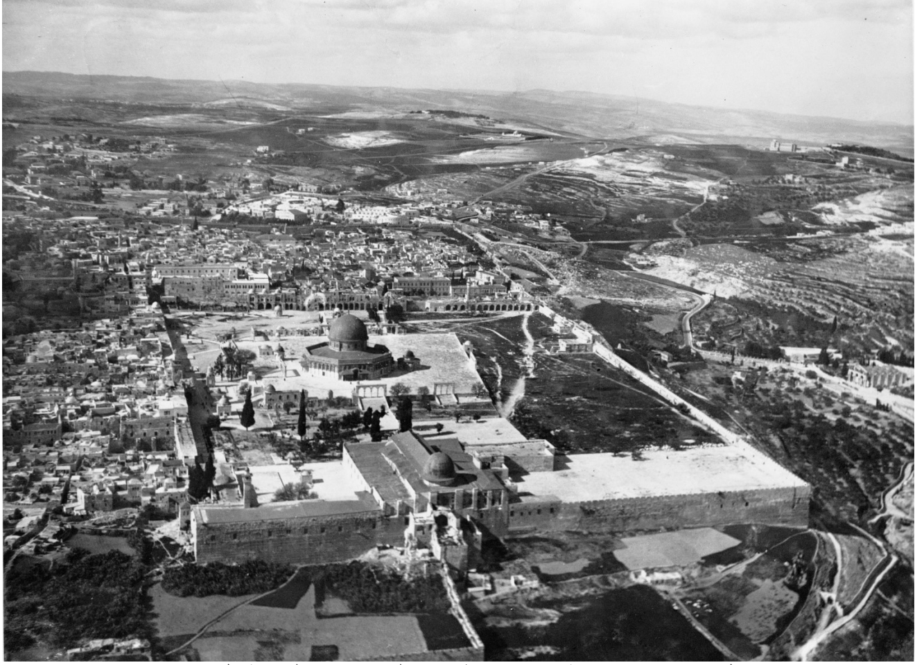
شكل رقم 28 صورة جوية عام 1931 يظهر فيها المسجد وحارة المغاربة قبل هدمها.
