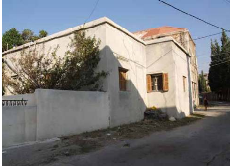
شكل (15.2) مبنى كاسا باترون من الخارج قبل الترميم وبعد الترميم.
