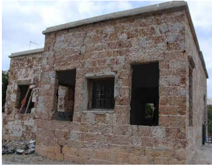
شكل (16.2) مبنى كاسا باترون - إزالة الإضافات واستعادة الطابع المعماري للمبنى.
