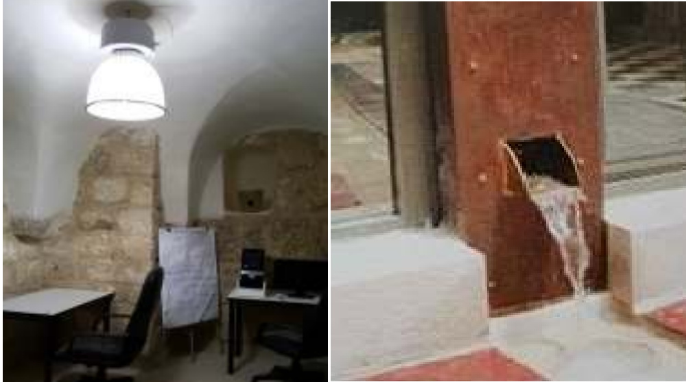
شكل (27.4): قصر الكايد، نظام تجميع مياه الامطار، ووحدات الانارة الموفرة للطاقة. المصدر: أرشيف رواق، الباحثة.
