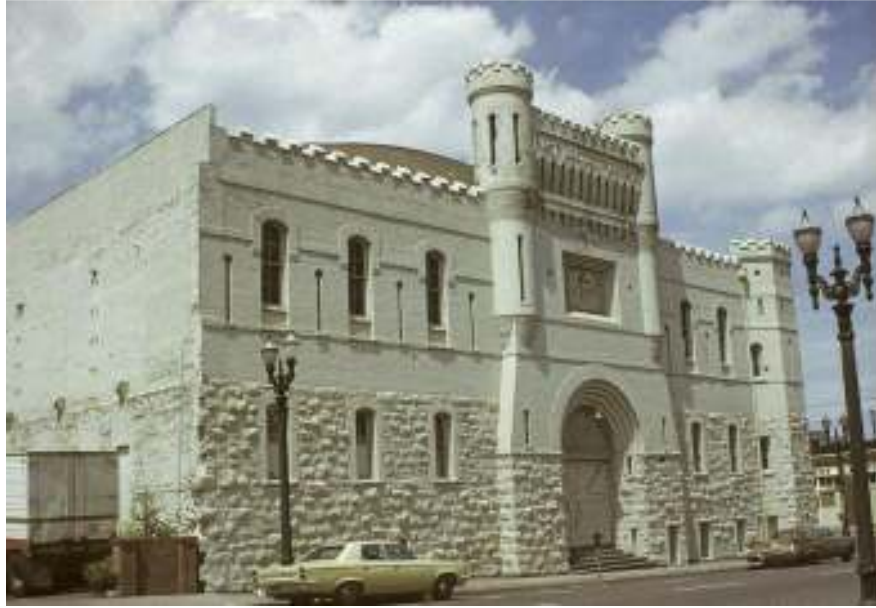
شكل (12.2) مبنى مخزن الكتب الأولى للأسلحة قبل الترميم.
