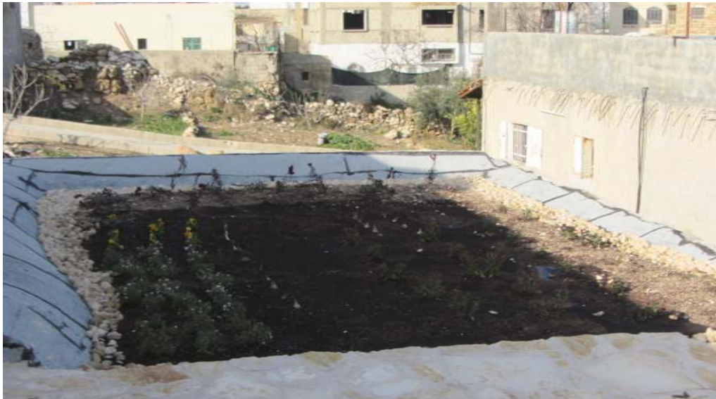
شكل (37.4): مبنى حوش محمود عثمان - تجربة السقف الاخضر.
