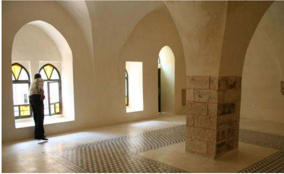
شكل (23.4): قصر الكايد من الداخل قبل وبعد الترميم
