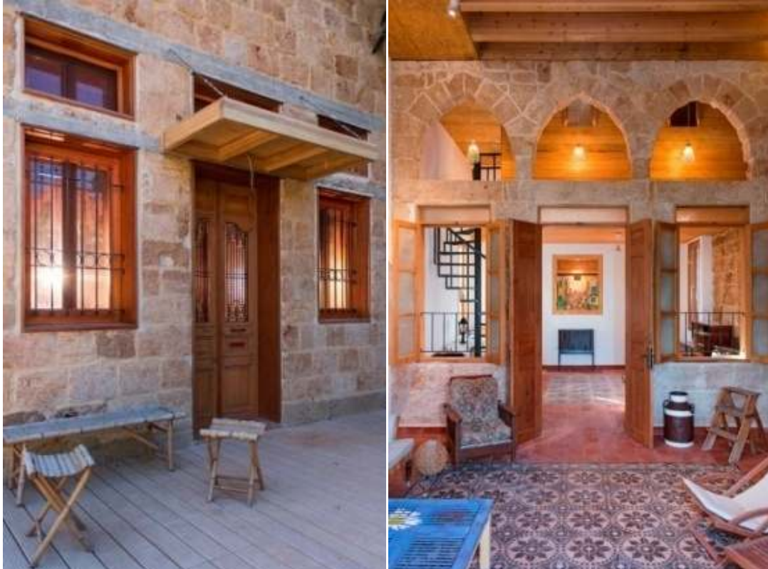
شكل (14.2) مبنى كاسا باترون بعد الترميم.
