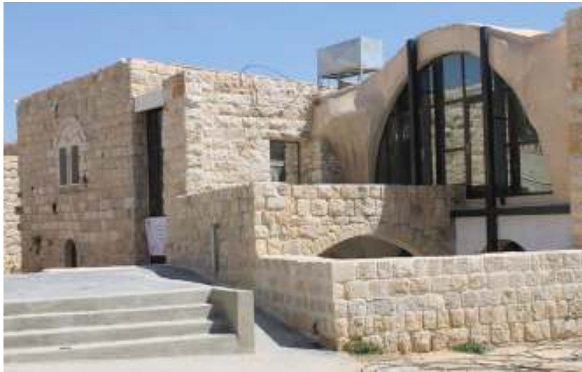
شكل (52.4): مبنى مركز نسوي وحديقة اطفال بيت اكسا قبل وبعد الترميم. المصدر: أرشيف رواق.
