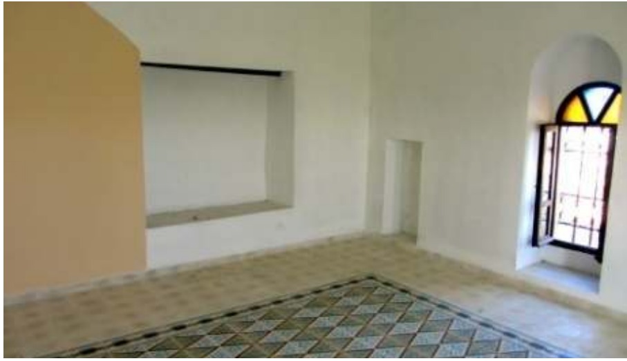
شكل (35.4): مبنى حوش محمود عثمان - من الداخل قبل وبعد الترميم.
