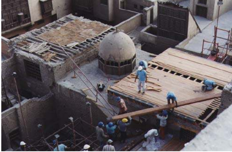
شكل (9.2): أعمال ترميم مبنى بيت السحيمي في القاهرة.
