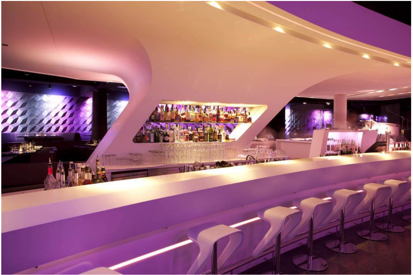
صورة (9) توضح استخدام خامة ال (corian) في البار .
