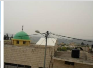
خطوط شبكة كهرباء
