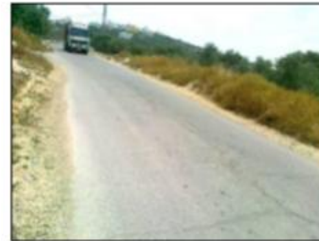
طرق في محيط البلدة تنتشر فيه التشققات وبدون أكتاف مدعمة
