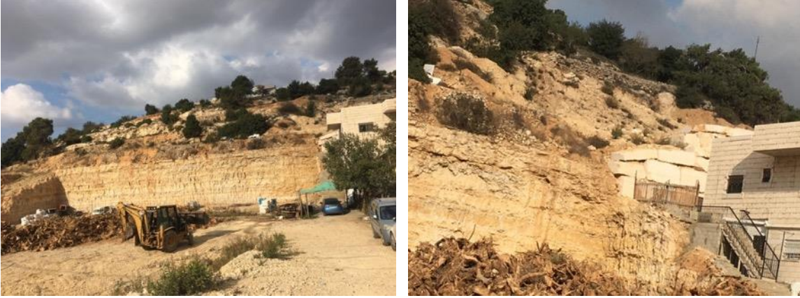
الشكل 3.18: استخدام الحفر لأعماق كبيرة كأسلوب لتسوية الموقع للبناء. المصدر: الباحثة.
