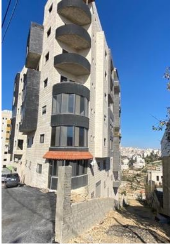
الشكل 3.23: عمارة سكنية على منحدر ضمن منطقة الدراسة
