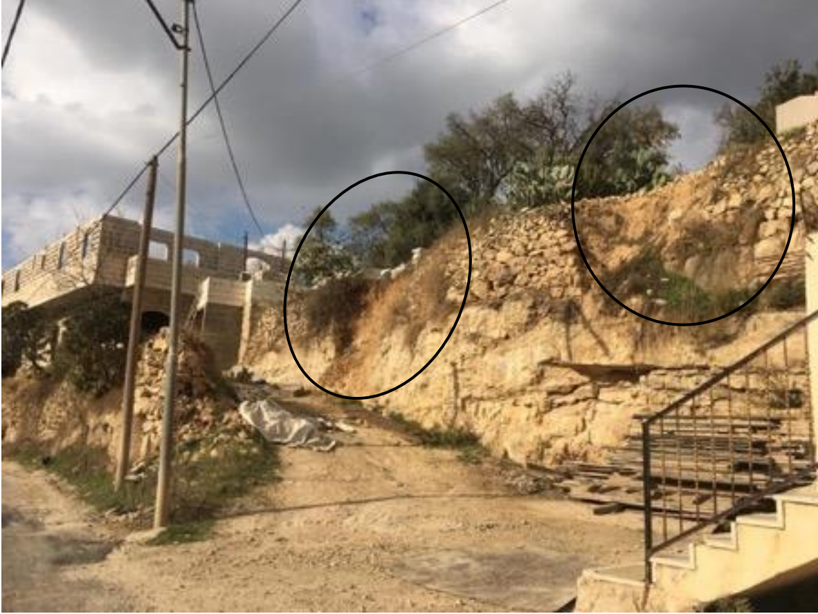
الشكل 3.14: انهيارات للجدران الحجرية إما نتيجة الخفر أو نتيجة انجراف التربة. المصدر: الباحثة.
