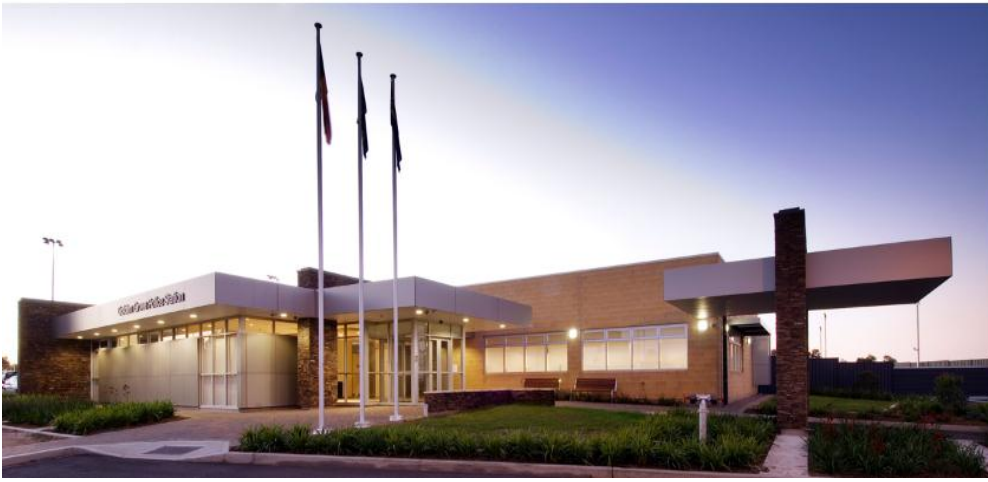
صورة (3-35): منظور خارجي لمركز الشرطة المصدر: (Greenway Architects,2010)
