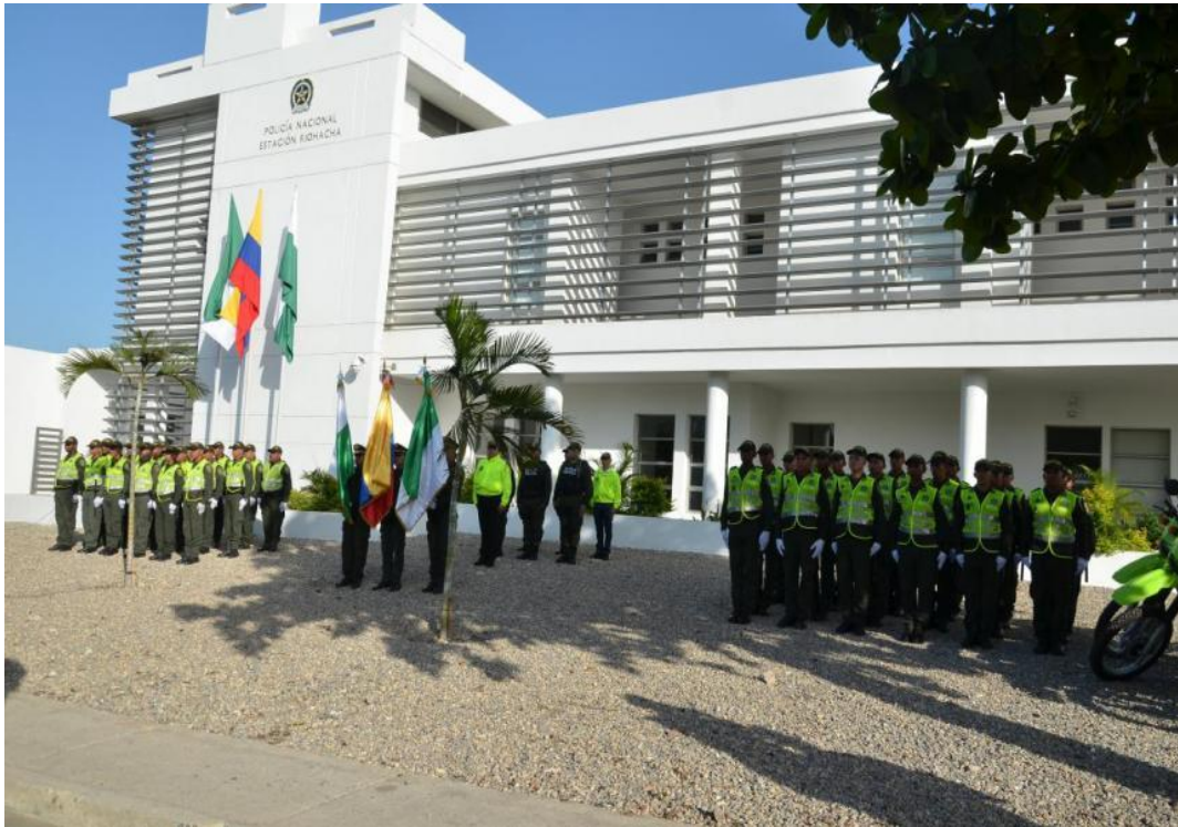
صورة (3-24): منظور خارجي للواجهة الشمالية في مركز شرطة ريوهاتشا. المصدر: (Elheraldo 2017)
