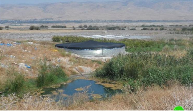
إخطار بوقف البناء لبركة مياه في قرية عين البيضا
