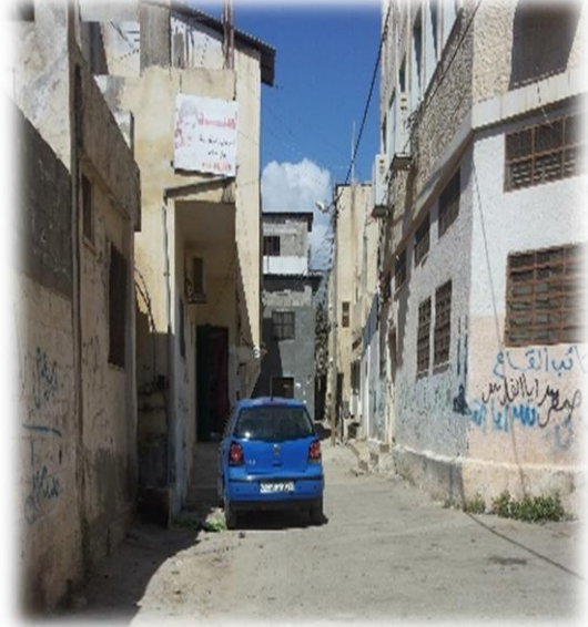
الصورة (40) : التناقض في مادة البناء
