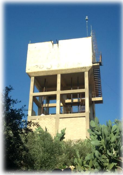
صورة (12) : خزان مياه
