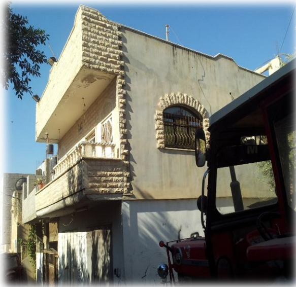
الصورة (41) : التناقض في مادة البناء
