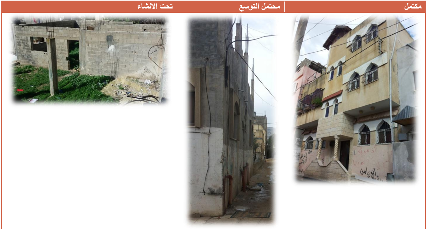
الصورة (32) : الوضع الانشائي للمباني الحالية
