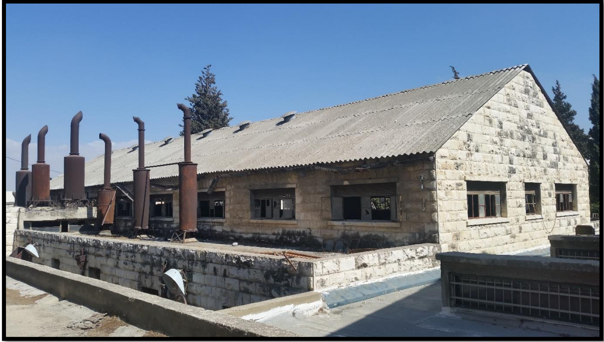
الشكل 4.22: صورة توضح المبنى الموجود في موقع الدراسة
