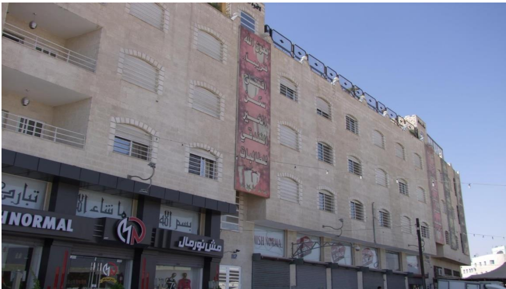
شكل 15: يوضح الشكل الواجهه الخارجية لسكن (الخير)،(2017).
