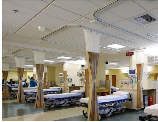
شكل 30 : استخدام الأسطح الممتصة للصوت في للسيطرة على الضجيج المصدر : (Archdaily, 2010)
