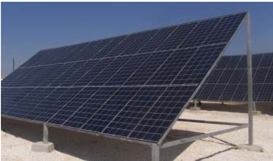
Figure (6.5): Atouf PV array (90 modules 135Wp).
