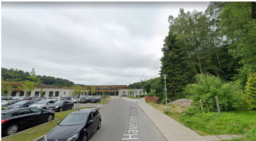
صورة 21. 2: صورة توضح المدخل الرئيسي للمشروع مع ساحة المواقف و الغابة المحيطة مصدر الصورة: google maps
