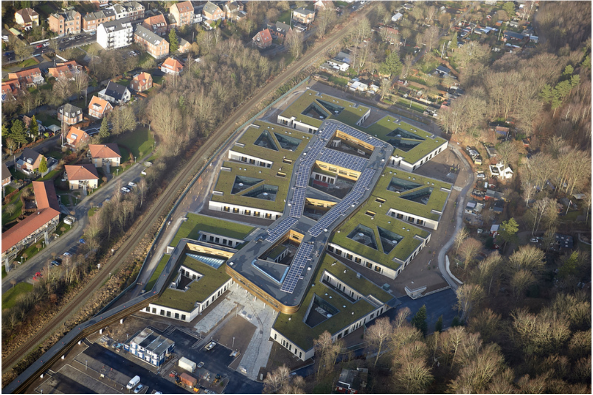
صورة 2. 38: صورة توضح الخلايا الشمسية و الاسطح الخضراء مصدر الصورة : www.archdaily.com
