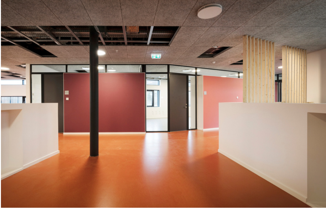
صورة 2. 31: صورة توضح استخدام الواح السقف الصوتية و ارضيات ( linoleum ) مصدر الصورة : www.arkitema.com
