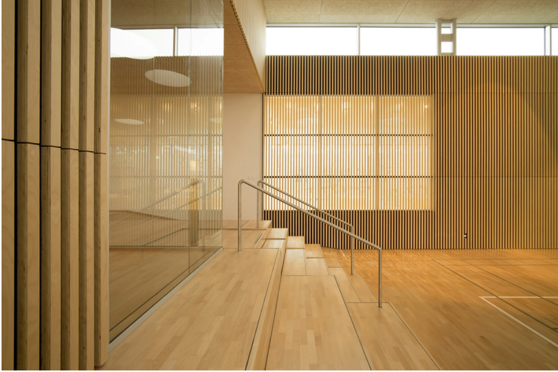
صورة 3. 40: استخدام شرائح خشبية لتعزيز امتصاص الصوت في PSYCHIATRIC HOSPITAL IN SLAGELSE المصدر : www.divisare.com
