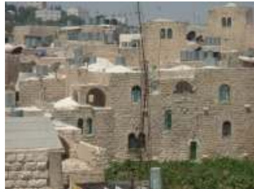
شكل (4-7) صورة عامة للمباني في البلدة القديمة بالخليل.
