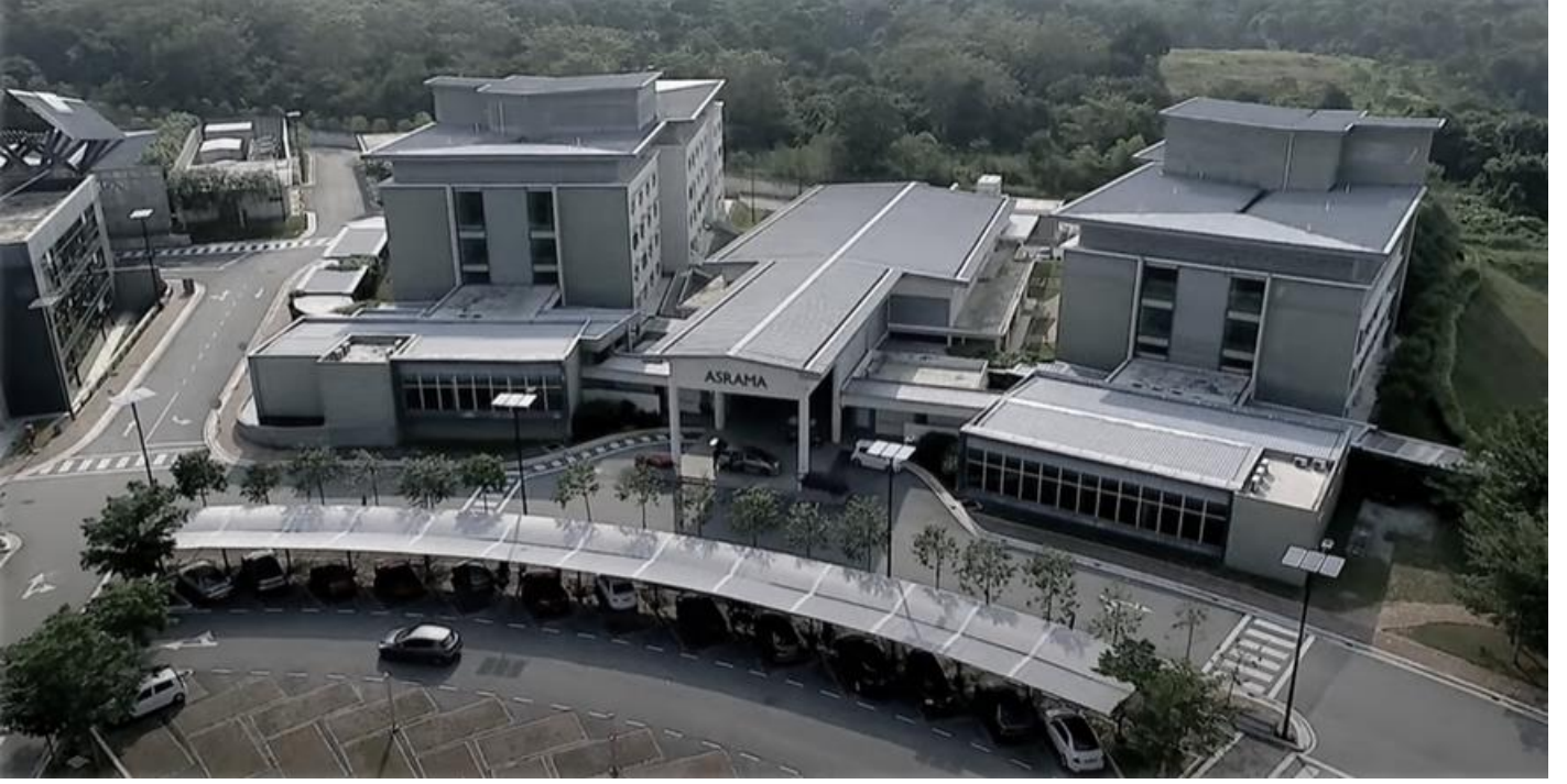
الشكل ( 17.2 ) : مبنى المنامات والمصلى.
