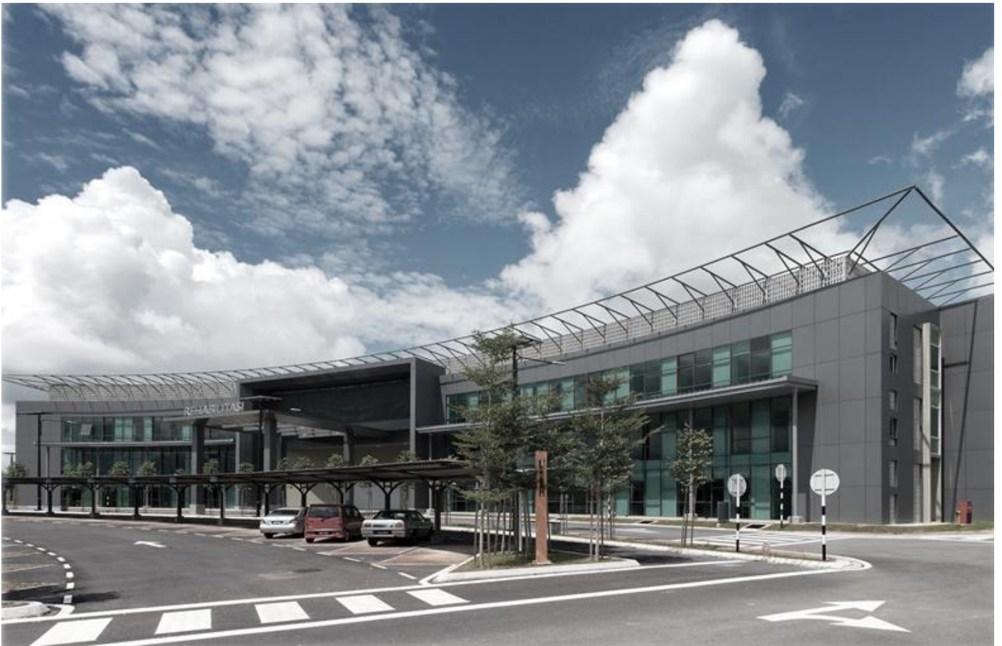
الشكل ( 1.2 ) : مركز سوكسو لإعادة التأهيل لذوي الإحتياجات الخاصة.
