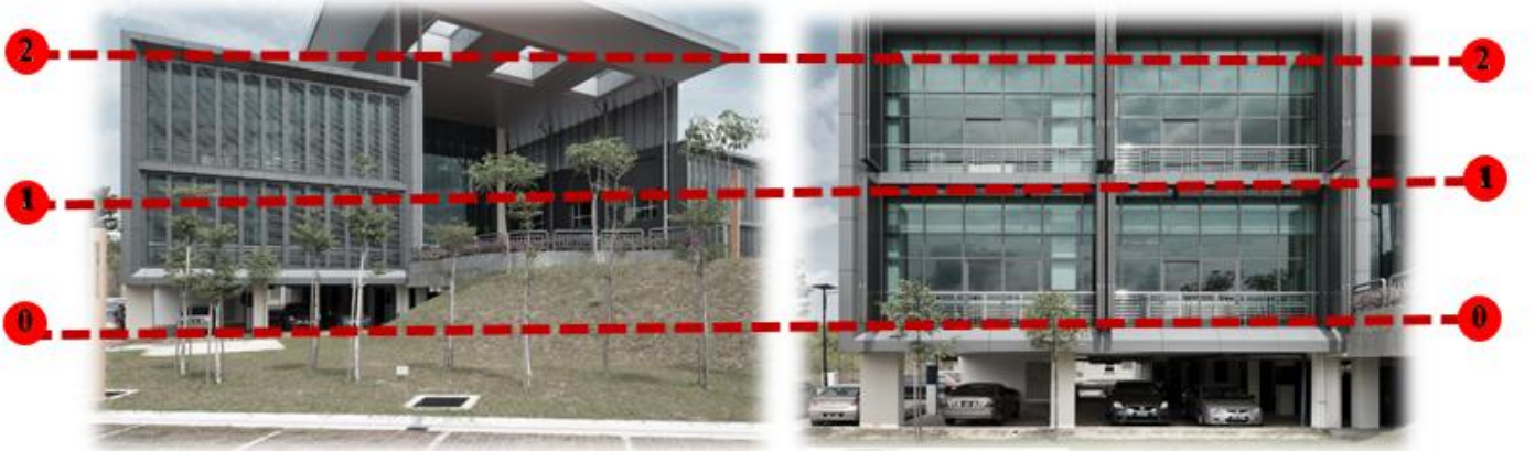
الشكل ( 13.2 ) : عدد طوابق مبنى قسم الادارة.
