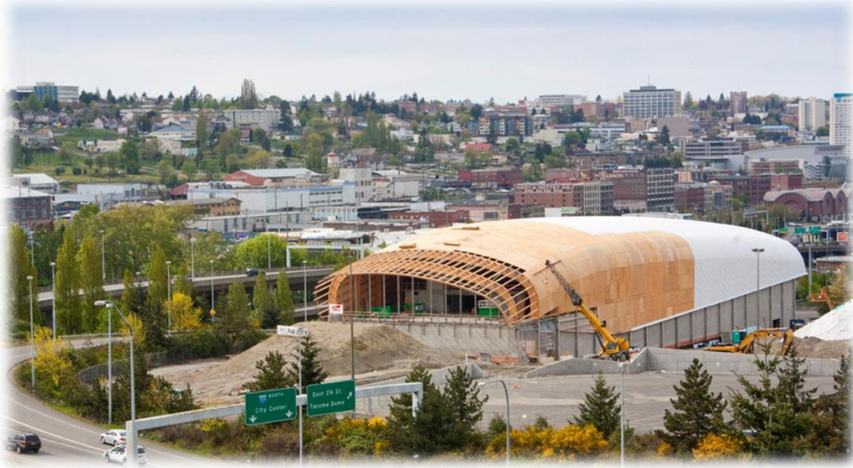
الشكل 1 :صورة توضح المشروع اثناء انشائه.
