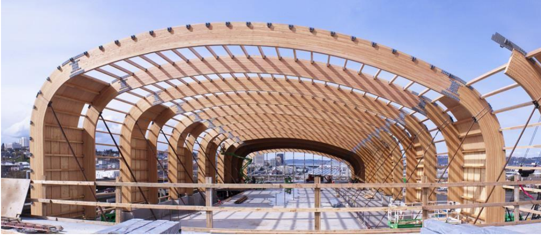
الشكل 11 : صورة توضح الهيكل النشائي في المشروع.
