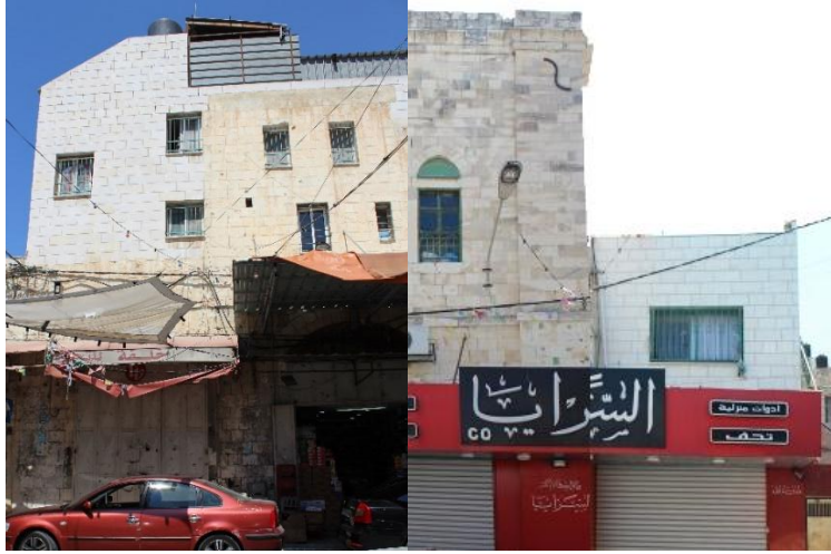
صوره 4-10: الإضافات فوق البناء القديم والبناء الغير منسجم مع المجاور - شارع حطين
