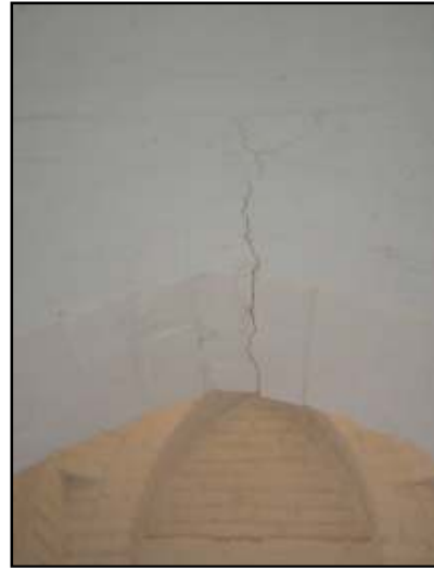
صورة (6: 16): شرح رأسي في أقواس الطوب الطيني في مركز الديوك النسوي (المصدر: الباحثة.2014)
