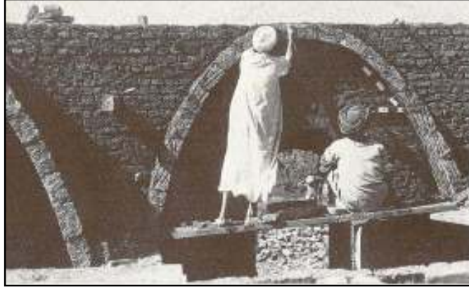
صورة (3: 22): إدخال الحشوات الجافة بعد اكتمال أول حلقة في القبو النوبي (المصدر: فتحي. 1989. ص17)
