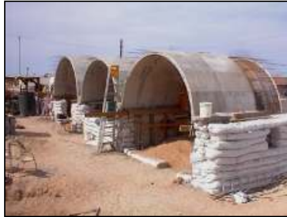
صورة (3: 9): استخدام الطوبار في أقبية أكياس الطين (المصدر: http://www.earthbagbuilding.com )
