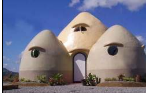
صورة (3: 8): عيادة في الفلبين مبنية بتقنية الأكياس الطينية (المصدر: http://www.earthbagbuilding.com )
