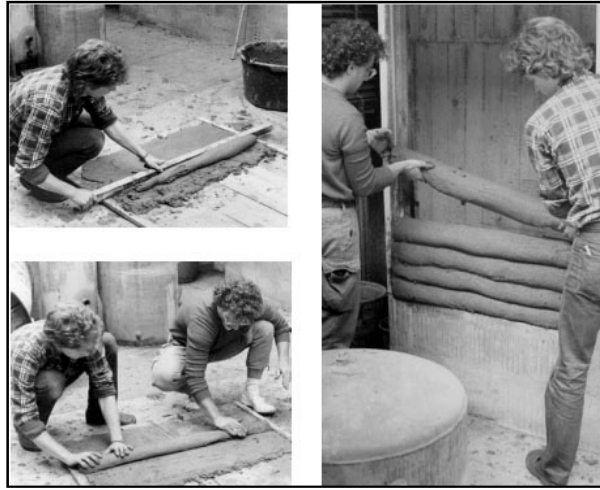
صورة (3: 13): لفائف الطين المستخدمة في تقنية الهيكل الخشبي (المصدر: Minke.2006.p82)
