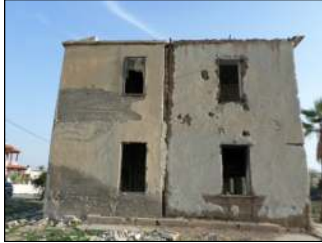
صورة (5: 28): تأثير إضافة مبنى خرساني ملاصق للمبنى الطيني في تدهور حالته الإنشائية (المصدر: الباحثة)
