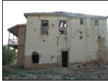
صورة (5: 22): استخدام التربة الحورية في قصارة واجهات بيت القرميد - مدينة أريحا. (المصدر: الباحثة)
