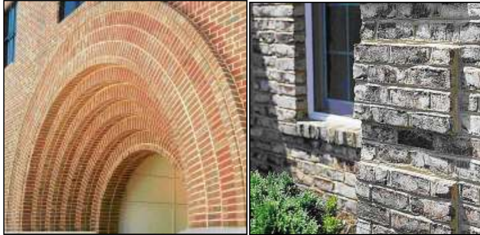
صورة (3: 15): مرونة التشكيل في الواجهات باستخدام الطوب الطيني المحروق (المصدر: http://www.gobrick.com )
