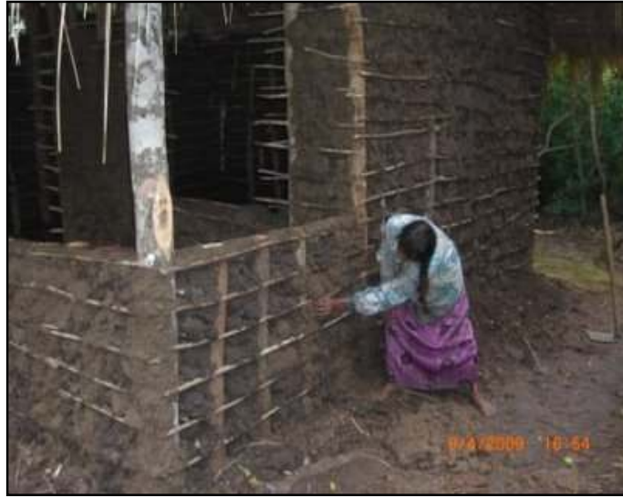
صورة (3: 12): طريقة البناء بتقنية Wattle and Daub (المصدر: Molla.2012.p17)
