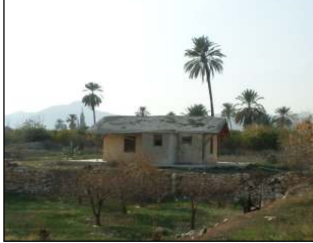
صورة (5: 4): سقف جملوني لمبنى طيني عند المدخل الجنوبي لمدينة أريحا (الباحثة)
