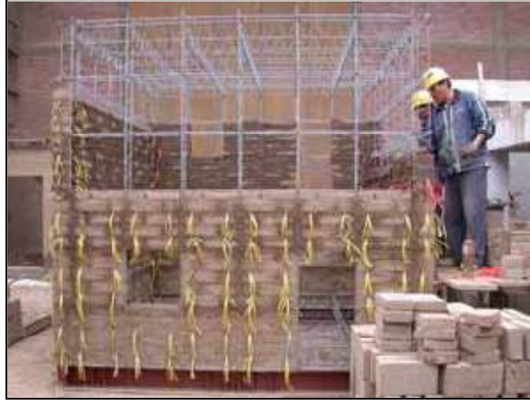
صورة (6: 20): استخدام نظام "Integral Masonry Systems" في المباني الطينية (المصدر: Blodet.2011.p11)
