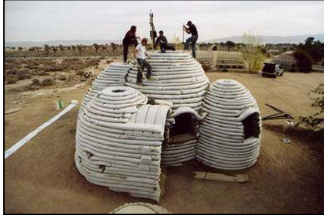
صورة (3: 6): استخدام اللفائف بدلا من الأكياس المنفردة في البناء بتقنية الأكياس الطينية
