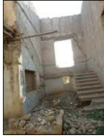
صورة (5: 15): الدرج الداخلي في فندق القصر الشتوي - مدينة أريحا (المصدر: الباحثة. 2014)
