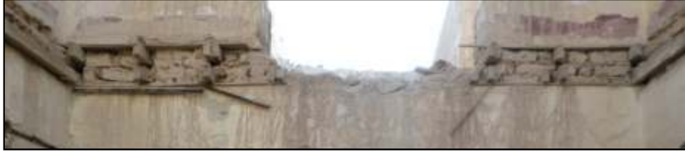
صورة (5: 16): المرحلة الأولى من إنشاء سقف الطابق الأرضي في فندق القصر الشتوي (المصدر: الباحثة)
