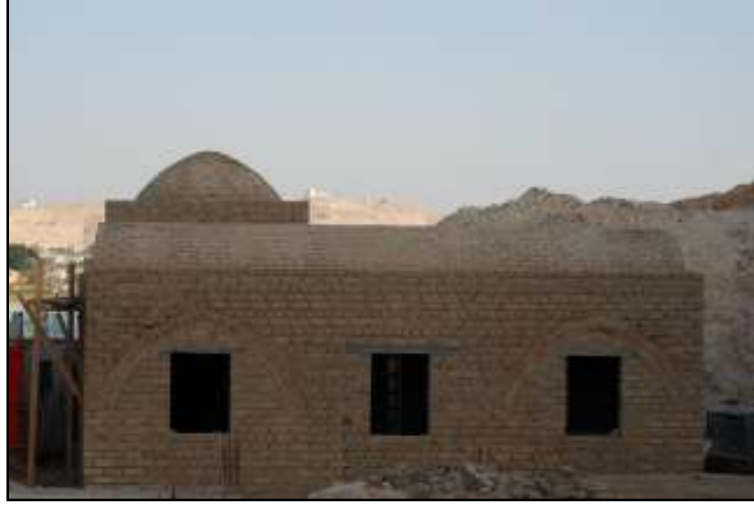
صورة (6: 4): مبنى مركز الديوك قبل عملية القسارة.
