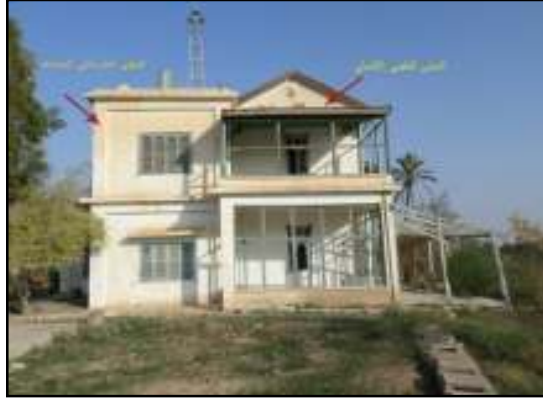
صورة (5: 24): المبنى الخرساني المضاف للجزء الطيني في بيت العلمي (المصدر: الباحثة. 2014)
