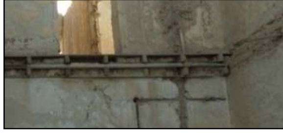
صورة (5: 19): التأسيس لتمديدات المياه في سقف الطابق الأرضي لفندق القصر الشتوي - مدينة أريحا (المصدر: الباحثة. 2014)
