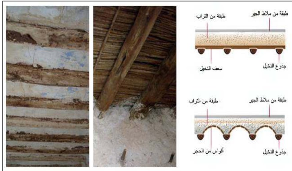
صورة (3: 17): التفاصيل البنائية في الأسقف الطينية المستوية (المصدر:البنية الطينية وصيانتها بوادي ميزاب. ص20)
