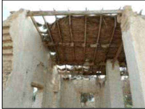
صورة (5: 11): سقف مسجد النويعة من الداخل. (المصدر: الباحثة. 2014)
