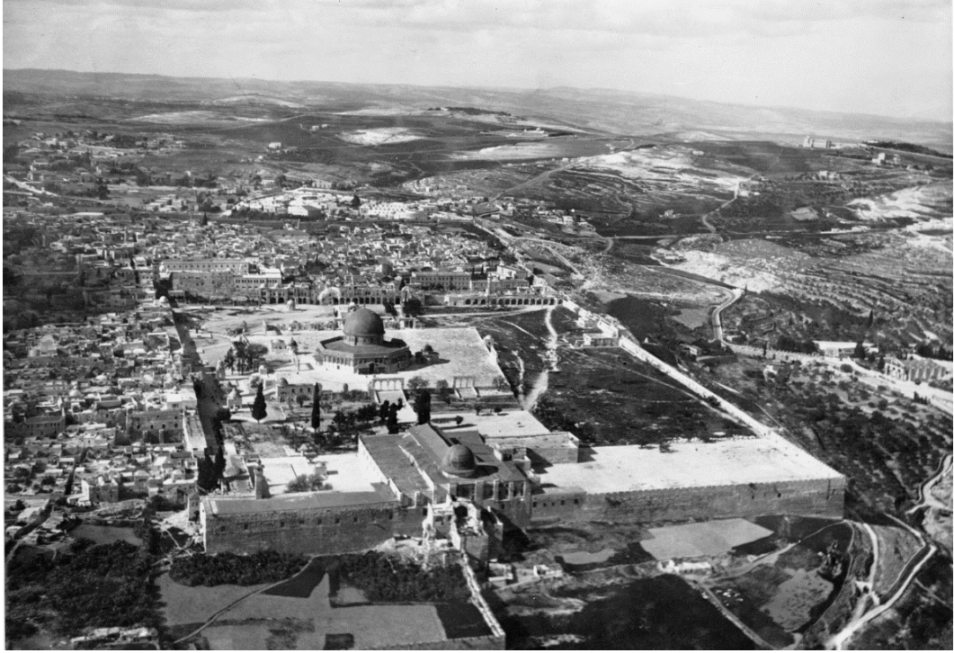
(صورة 3.9): صورة جوية عام 1931 يظهر فيها المسجد وحارة المغاربة قبل هدمها. (عبد الرازق 2013)
