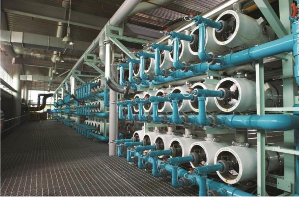
صورة (10): تنقية المياه المستخدمة باستخدام تقنيات الأغشية المتقدمة.
