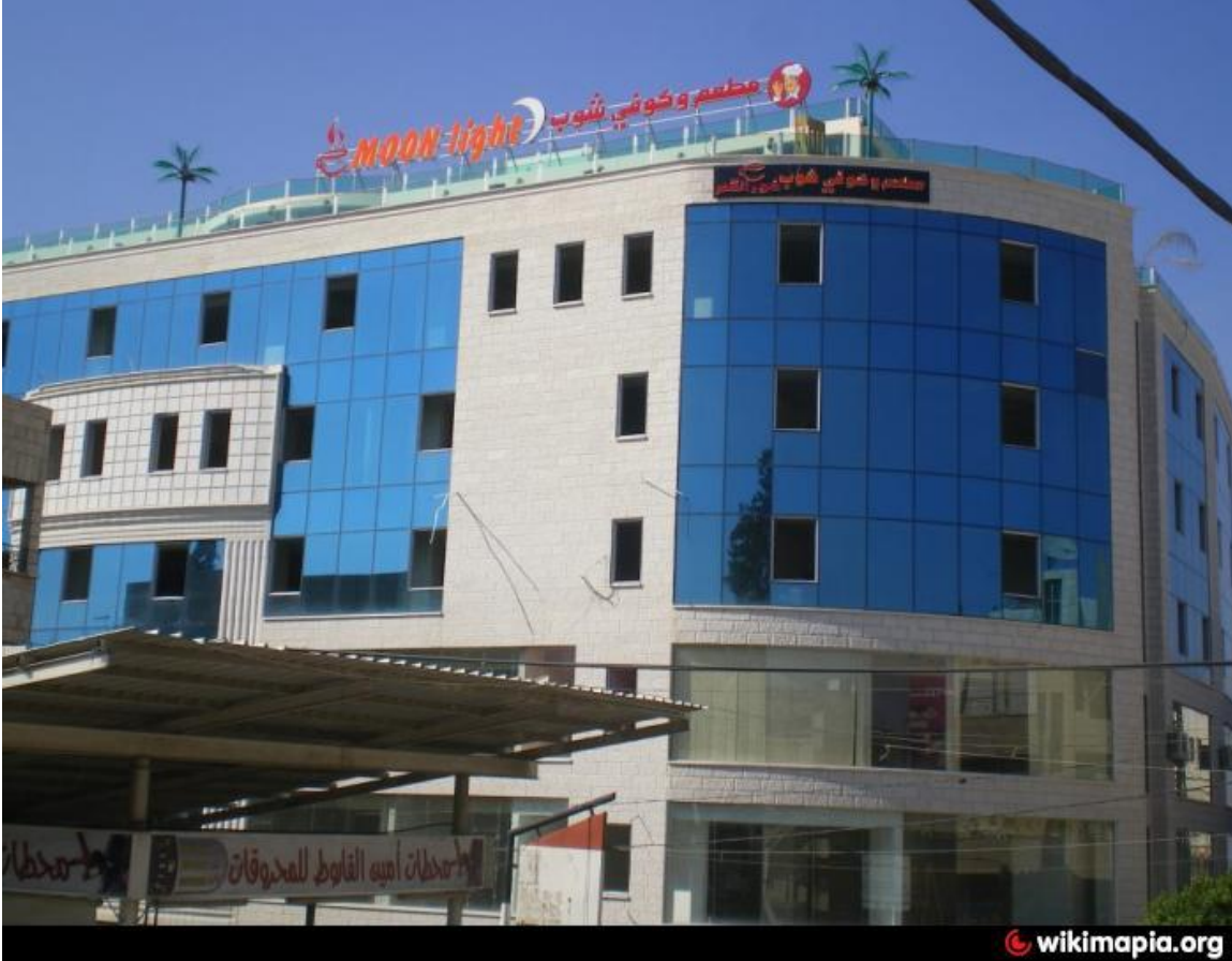
صورة 34: توضح الشكل الخارجي للمول.
