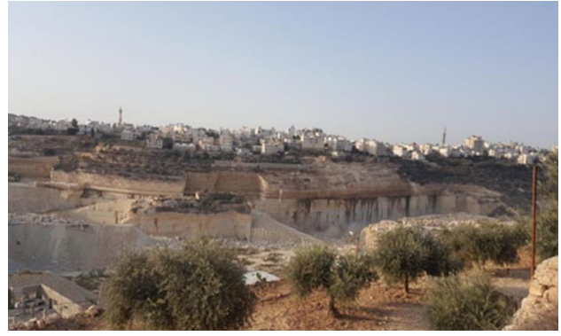
صورة 5: مقالع الحجر في بلدة تفوح شمال الخليل تهدد مجرد وجود المباني السكنية المصدر: مجلة أفاق التنمية العدد 112 - 2019
