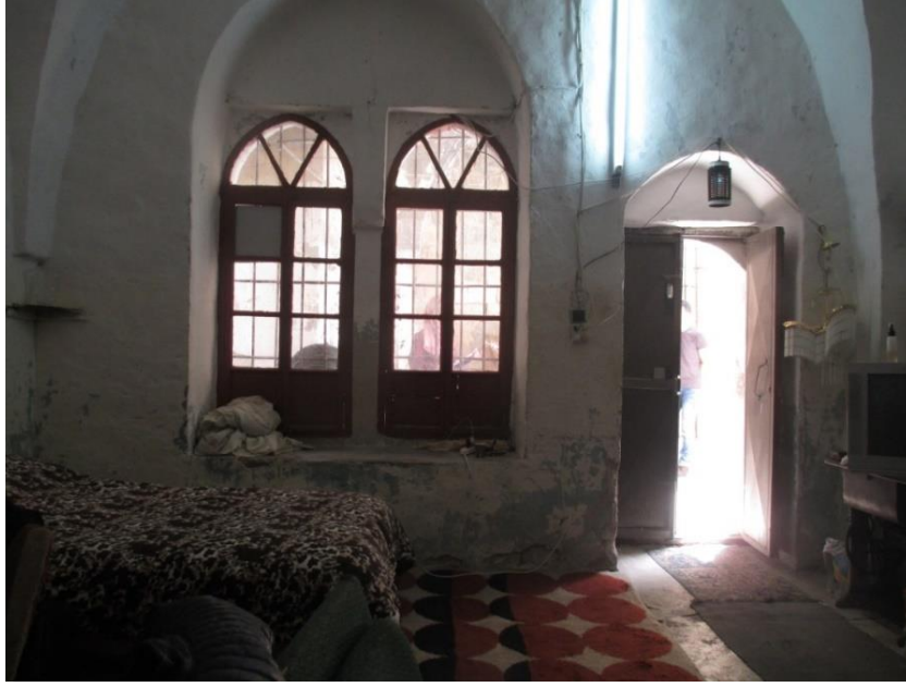
الشكل (3.26): إحدى الغرف في منزل عائلة طقطق والفتحات الداخلية في المبنى . المصدر : ( وحدة المباني القديمة التابعة لبلدية نابلس، 2019).
