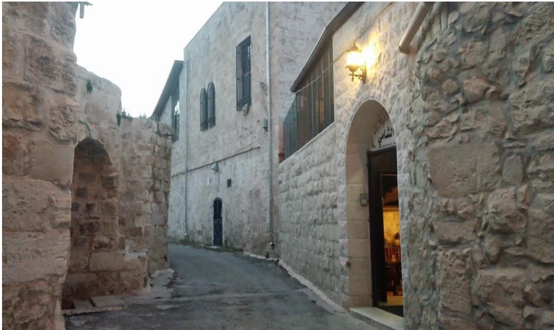
الشكل (3.7): صورة توضح مادة البناء وارتفاعات المباني والمسافة بينها في رفيديا القديمة. المصدر: (العيسى، 2015).
