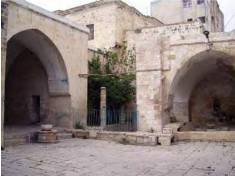
الشكل (2.20): الفناء الرئيسي في قصر نمر في مدينة نابلس. المصدر: (مؤسسة التعاون، 2011).
