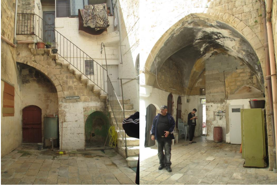
الشكل (3.25): العقد المتصالب فوق المدخل ودرج المنزل الموجود في الفناء الوسطي المصدر : ( وحدة المباني القديمة التابعة لبلدية نابلس، 2019).
