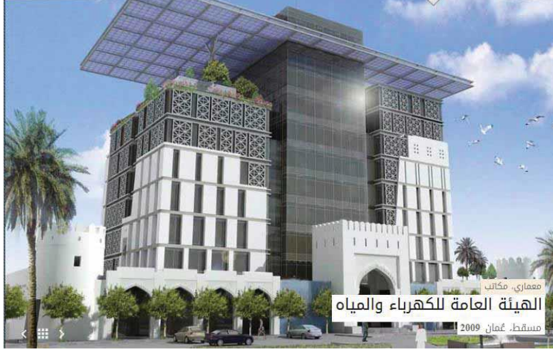
الشكل (4.15): صورة عامة لمبنى الهيئة العامة للكهرباء والمياه في سلطنة عُمان المصدر: (العنسي، 2016)
