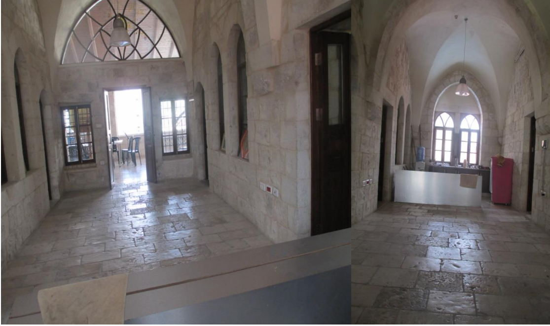
الشكل (3.18): صورة الفراغ المغطى بالقرميد في الطابق الأول لمركز أوتار المصدر: (وحدة المباني القديمة التابعة لبلدية نابلس، 2019).
