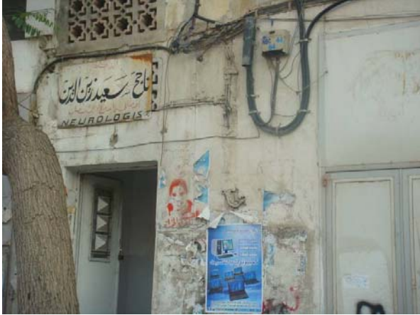
صورة(4-15) تظهر العشوائية بشكل واضح في توزيع أسلاك الكهرباء ويبدو التشوه البصري الناتج عن هذا التوزيع العشوائي وطغيانه على العناصر المعمارية في المبنى.
