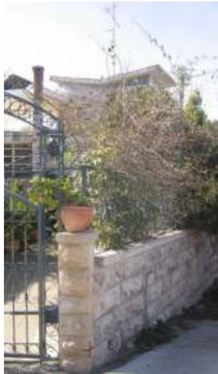
شكل (128): صورة توضح تغطية النباتات لأجزاء من المبنى.
