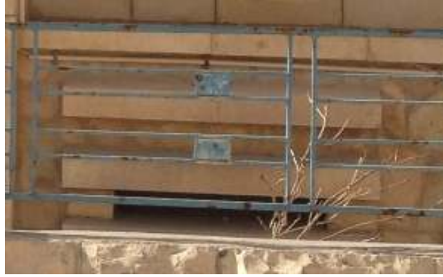
شكل (184): صورة توضح معالجة نوافذ الحمامات في المناطق التي بحاجة لخصوصية.
