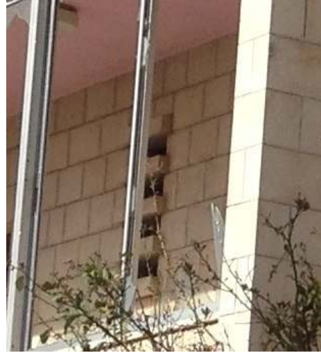
شكل (183): صورة توضح معالجة نوافذ الحمامات في المناطق التي بحاجة لخصوصية.
