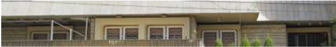
شكل (100): العلاقات بين الكتل بواسطة فصلها عن بعض بخط فاصل Groove.
