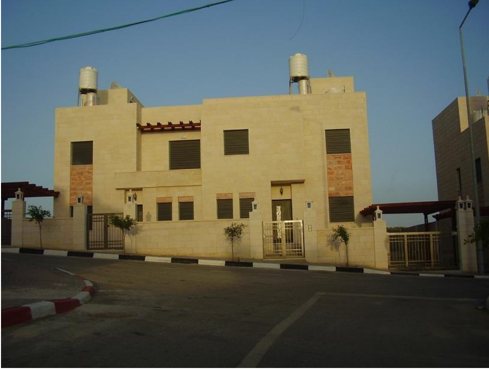
شكل (37) الواجهة الأمامية - الوحدات السكنية (المصدر الباحث)
