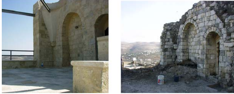
شكل رقم(26.5): الغرفة المهدامة في الطابق الثاني قبل وبعد الترميم(ظاهر 2007، بحث غير منشور)
