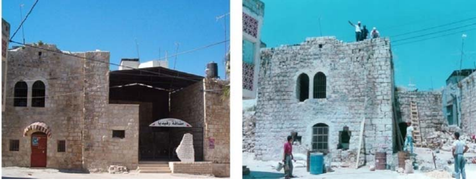
شكل رقم(8.4): صورة لمضافة رفيديا اثناء و بعد الترميم. (عاصي 2006، ص23)
