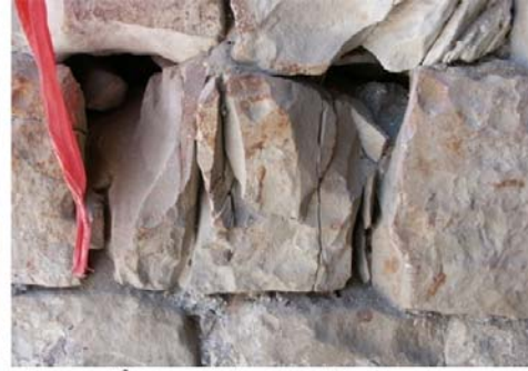
مجموعة من الحجارة في احد جدران المبنى وقد تآكلت وحصل فيها تهشيم كبير وقد وجب تدعيمها او استبدالها
