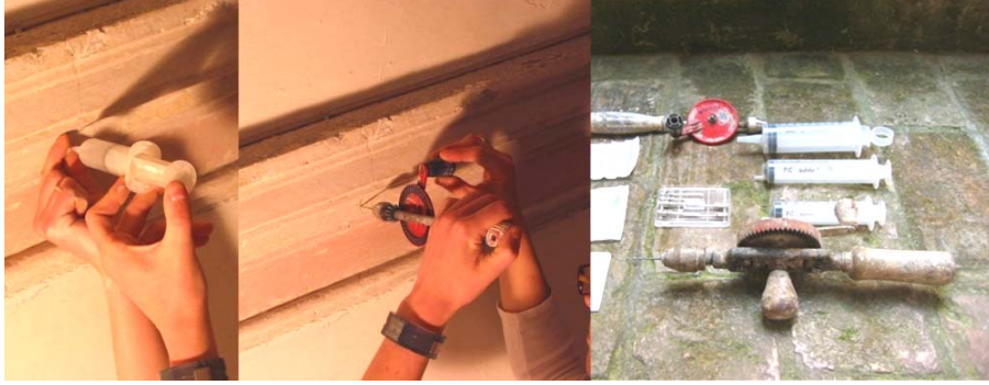
شكل رقم (5): حقن القصاراة و تقويتها (Docci, 2005)
