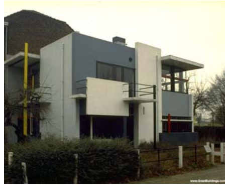
الشكل(14:3): مسكن شرويدر. (المصدر: www.greatbuildings.com).
