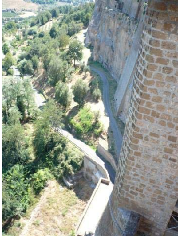
شكل (43:4): صورة توضح أعمال الترميم المنفذة للجدران وتجانسها مع ما يجاورها من الجرف الصخري.
