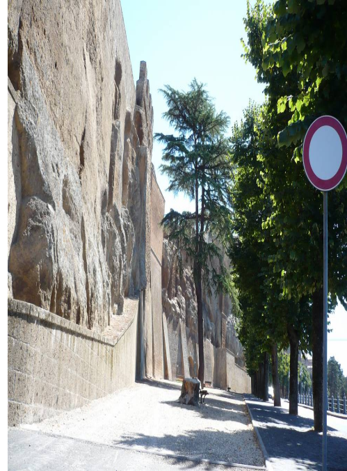
شكل (39:4) الصور أعلاه تظهر التجانس الكبير ما بين الصخرة وجدران التقوية أسفلها بعد تنفيذ أعمال التقوية والتثبيت.
