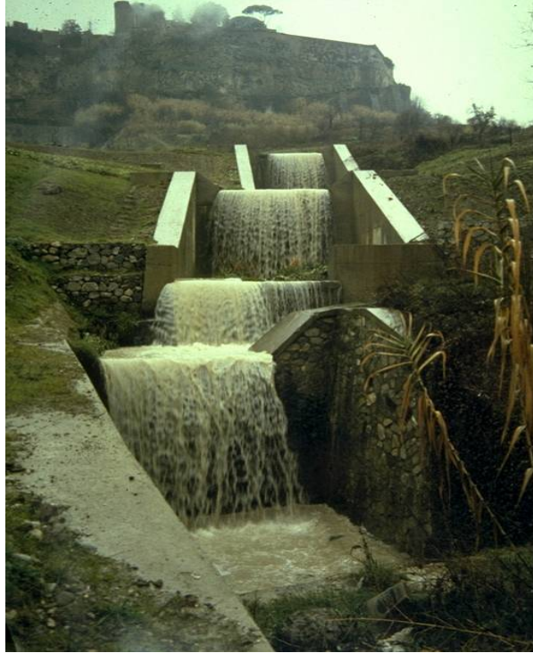
شكل (21:4): أعمال ترميم أحد الاخاديد الخمس المنتشرة حول الجرف الصخري.
