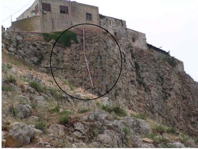
التشقو البصري الناخ عن عملية التصريف الصحي
