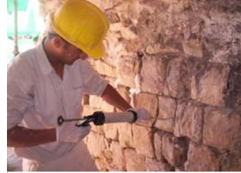
شكل (29:4): حقن فراغات الحجر بالمادة الغرائية باستخدام ابر الحقن الطبي. المصدر: (أرشيف مكتب خان الوكالة)
