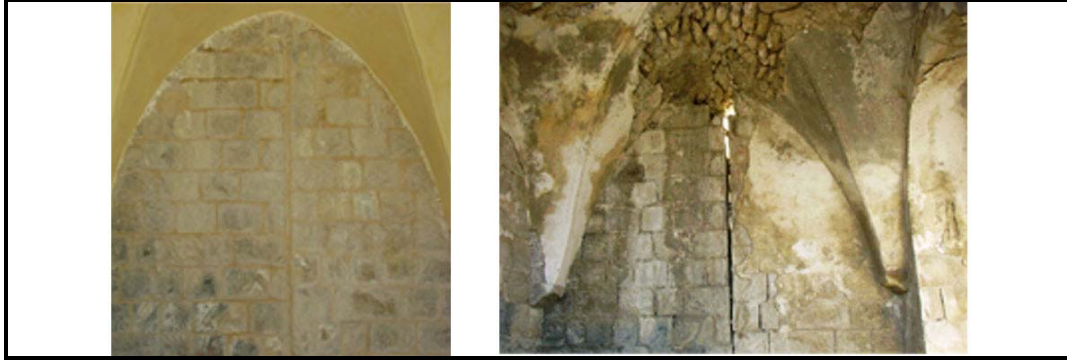
شكل (70:4): إغلاق الشقوق بتعبئة المونة داخلها. المصدر: (صالح، 2006).
