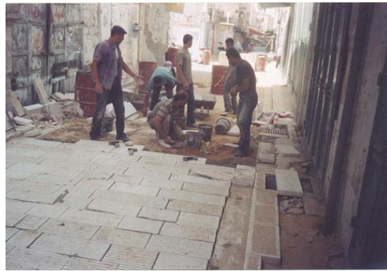
شكل (4:4): تبليط الشوارع في البلدة القديمة.
