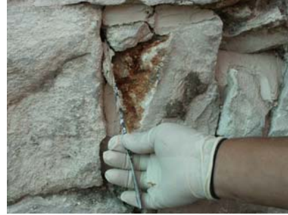
شكل (31:4): استخدام الأزميل الرفيع من أجل تنظيف حلول الحجر.
