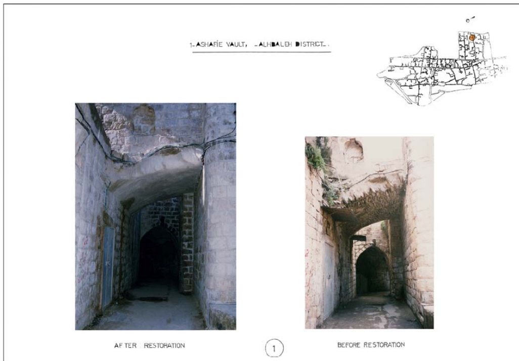
شكل (2:4): قنطرة الشافعي قبل وبعد الترميم.
