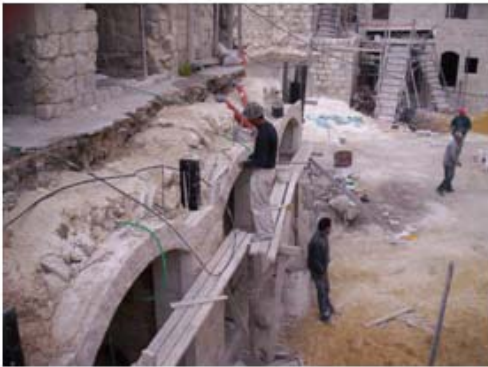
ربط الواجهة الجديدة بالقديمة
