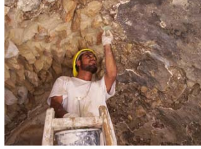
شكل (30:4): تنظيف الحجر بعد الحقن باستخدام الماء.
