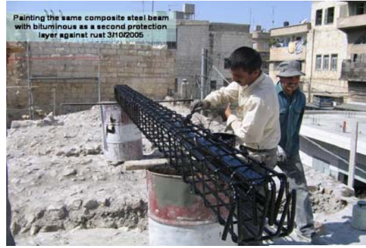
شكل (14:4): التوثيق الإنشائي أثناء الترميم.
