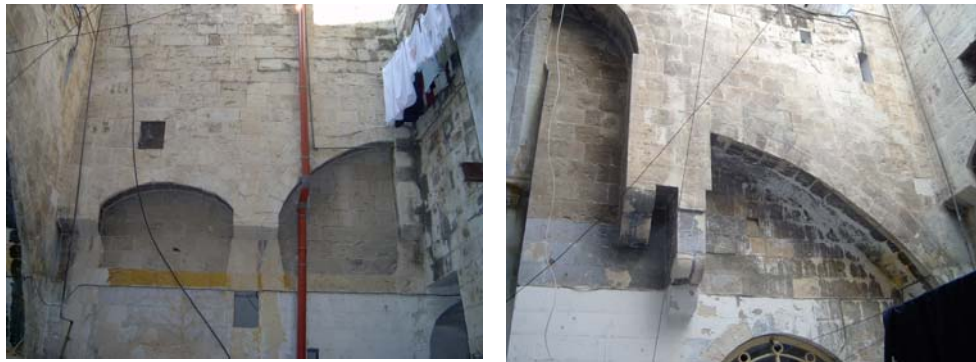
شكل (5-13): استعمال الكوابل في الواجهات الداخلية والخارجية لبيت عاشور في نابلس
