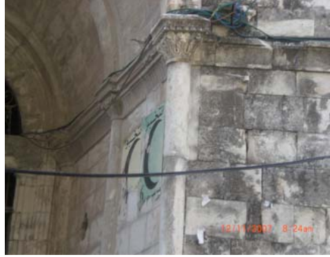
شكل (5-14): استعمال الأعمدة في زوايا المدخل الرئيسي لبيت النابلسي
