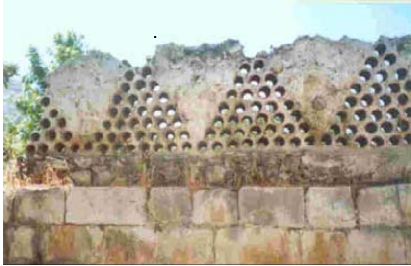
شكل (5-2): استخدم الكيزان حرمك قصر طوقان
