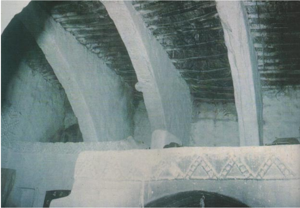
شكل (4-5): نموذج عن بيت القرية وذلك في قرية دورة الخليل، واعتمد السقف الخشبي المستوي المرتكز على قناطر حجرية نظاماً للتسقيف
