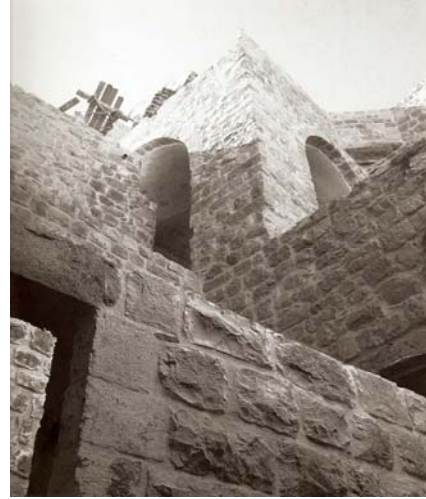
شكل (5-9): احد الاحواش في مدينة الخليل ويظهر استخدام المداميك
