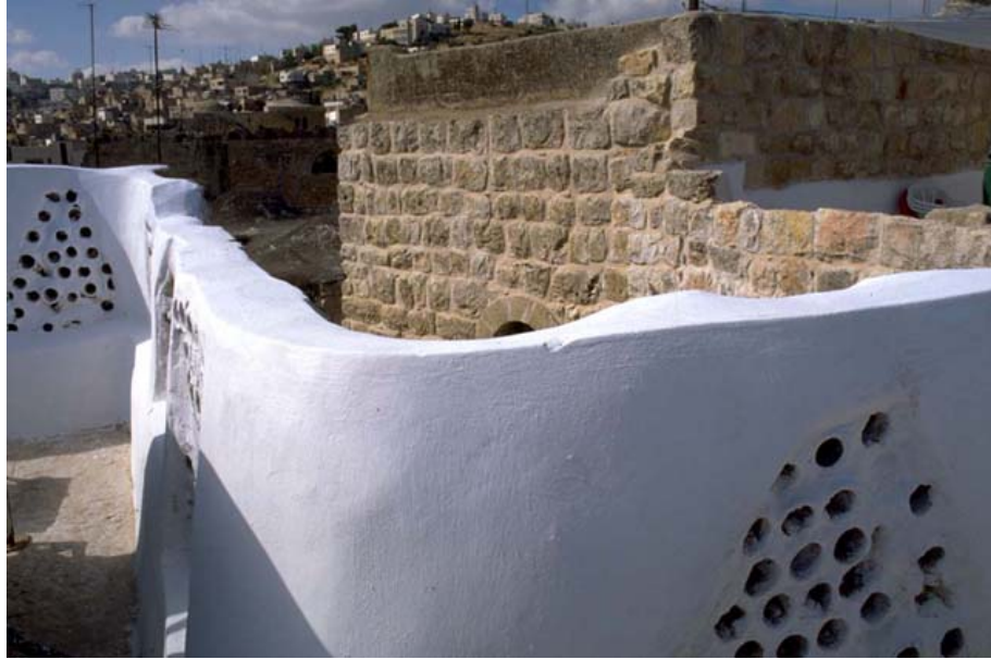
شكل (5-15): استعمال الكيزان في احد بيوت الخليل
