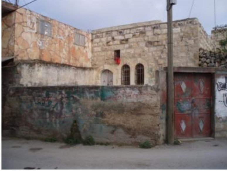
الشكل (5-24): صورة تظهر السور الإسمنتي الخارجي لمضافة القواريق وتظهر بوابة المدخل.
