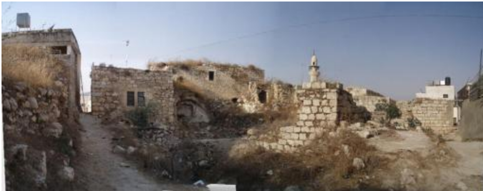
الشكل (5-111): صور لمنطقة البيوت المهدمة والمجروفة مقابل مضافة الدراوشة-المصدر: الباحثة
