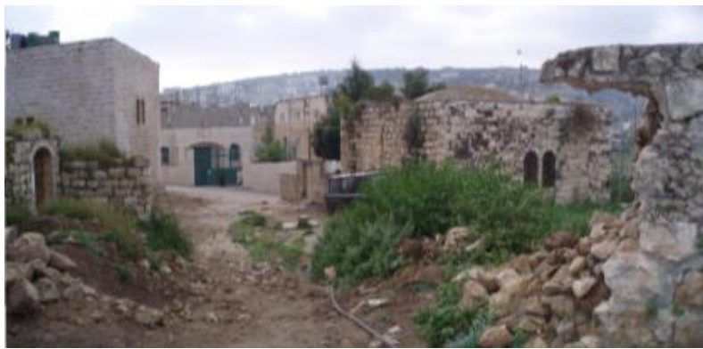
الشكل (5-90): صورة من الجانب الغربي تظهر المضافة والأرض المجاورة لها والملبئة بالحشائش والتي سيتم استملاكها وضمها لفراغ الساحة - المصدر: الباحثة
