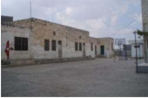
الشكل (4-81): صورة لأحد المدارس القديمة
