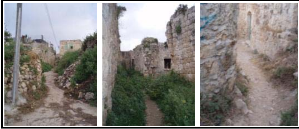
الشكل (5-106): صور لبعض الطرقات القديمة بوضعها الحالي-المصدر الباحثة
