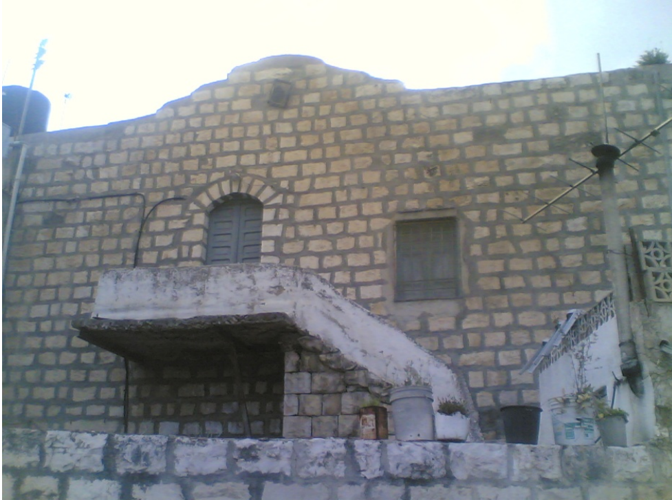
صورة رقم (7): الكحلة بالاسمنت الأسود والرمل.
