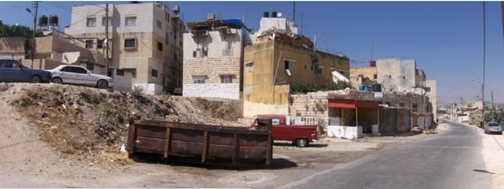
شكل رقم (5،12) : بانوراما متعددة تظهر فيها واجهات المباني التي تحدد الشارع رقم 3 المصدر: الباحثة.
