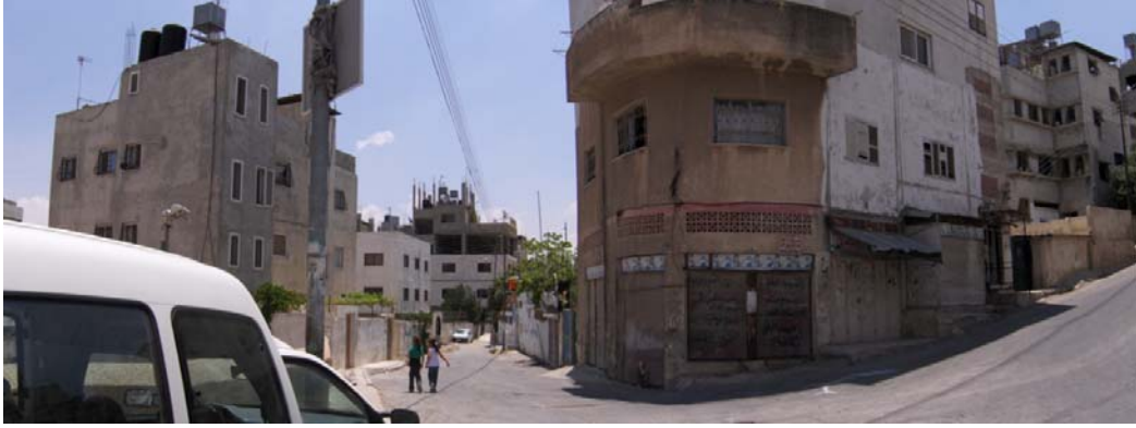
شكل رقم (5،11) : بانوراما مأخوذة للشارع رقم 2 من ساحة العين تظهر فيها واجهات المباني الحديثة التي تحد الشارع من الجهة الشرقية. المصدر: الباحثة.
