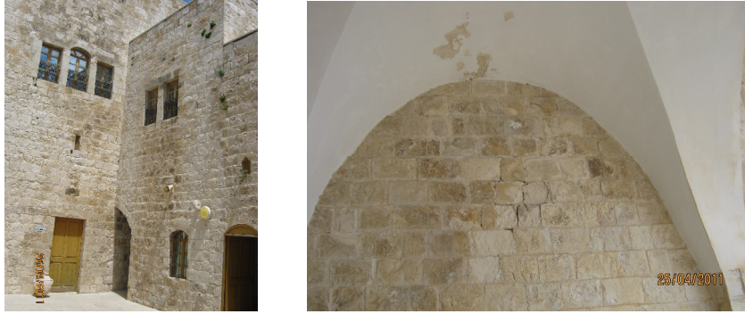
شكل رقم (90): صورة توضح امتصاص الحجر للماء وظهور الأملاح والأعشاب وتفتت الحجر. المصدر: الباحث.
