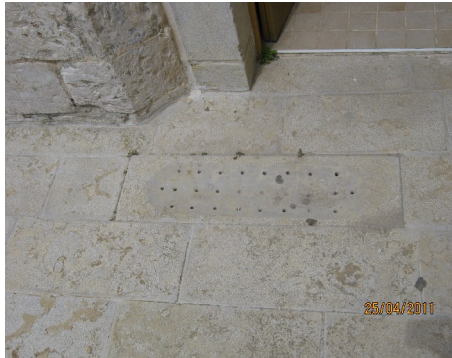
شكل رقم (87) : صورة توضح تمديدات الصرف وكيفية معالجتها في الفناء والحمام المضاف. المصدر: الباحث.
