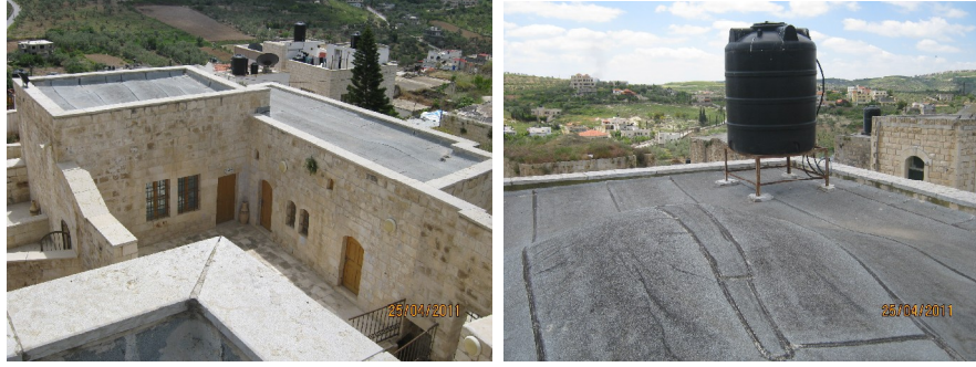
شكل رقم (78): صورة توضح عزل القباب والأسطح والجبهة الحجرية وذلك لحماية المبنى من تسرب المياه إلى داخل الغرف وتوضح ظهور خزان المياه على السطح. المصدر: الباحث.
