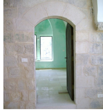
شكل رقم (115): صورة توضح تميز الحجر الحديث المضاف عن الحجر القديم وذلك للحفاظ على الأصالة العلمية في عملية الترميم. المصدر: الباحث.
