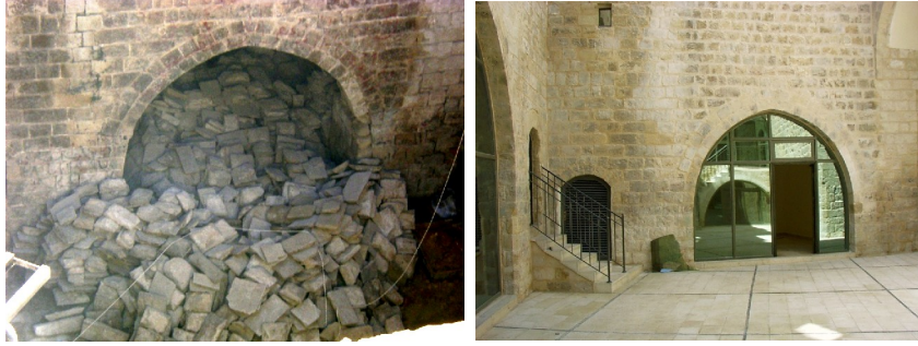
شكل رقم (124): صورة توضح إغلاق واجهة الإيوان بواجهة زجاجية وإضافة أبواب خشبية. المصدر: الظاهر، 2006.
