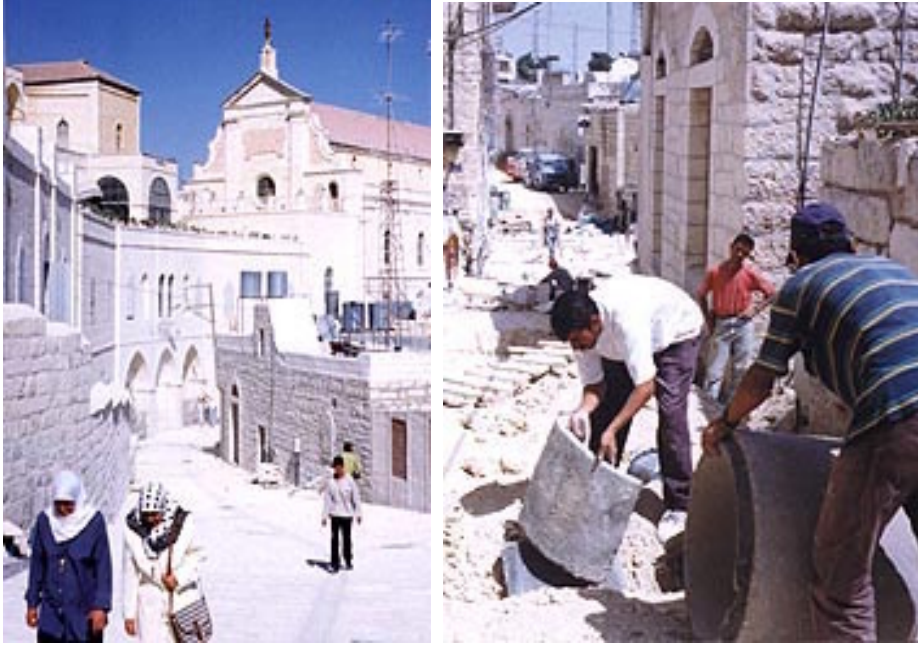
شكل رقم (37): صورة توضح أعمال ترميم شارع الساليزان (أيلول / 1999) في مشروع بيت لحم 2000.
