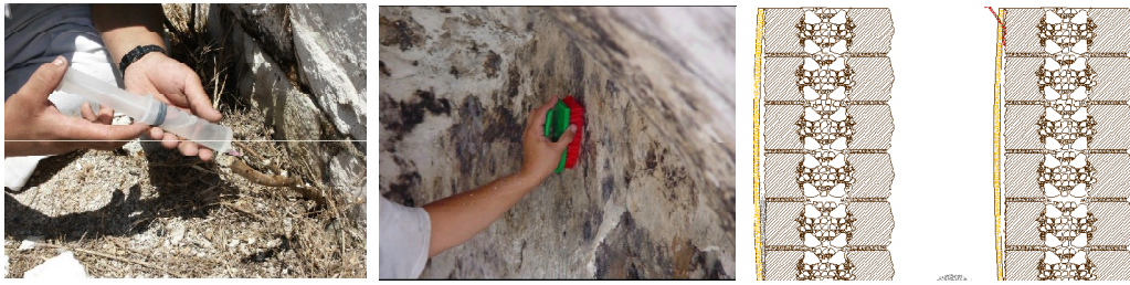
شكل رقم (57): صورة توضح طريقة التعامل مع القسارة الجيرية وتنظيف القسارة بالفرشاة وحقن النباتات الضارة. المصدر: أرشيف رواق.
