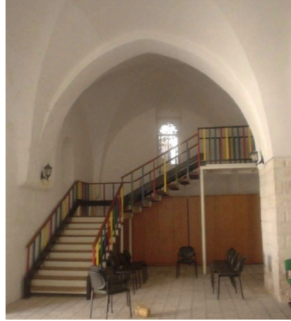
شكل رقم (30): صورة داخل مركز الطفل الثقافي بعد الترميم. المصدر: بلدية نابلس.
