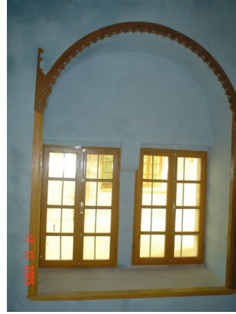
شكل رقم (81): صورة توضح الشبائيك الخشبية وبراويز الشبائيك الأصلية في قصر عبد القادر عبد الهادي. المصدر: أبو علي، 2006.
