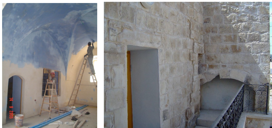
شكل رقم (75): صورة توضح كيفية معالجة تصدع في الواجهة الحجرية، وطريقة التعامل مع القسارة الجيرية. المصدر: أبو علي، 2006.
