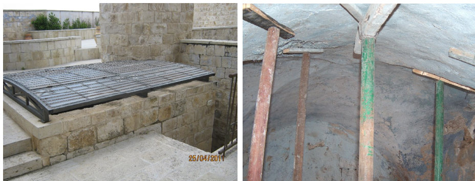
شكل رقم (73): صورة توضح تدعيم الأسقف في يمين الشكل والى اليسار معالجة عن طريق إضافة سقف من الحديد و(الفيبر غلاس). المصدر: أبو علي، 2006.
