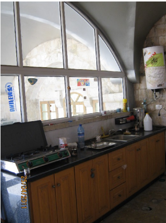
شكل رقم (82): صورة توضح الإضافات على المبنى عن طريق إعادة تسقيف المطبخ وعمل واجهات زجاج وألمنيوم. المصدر: الباحث.
