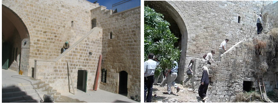
شكل رقم (76): صورة توضح أعمال معالجة الحجر من إكمال أحجار ناقصة إلى إزالة الأعشاب من بين الحجر. المصدر: أبو علي، 2006.
