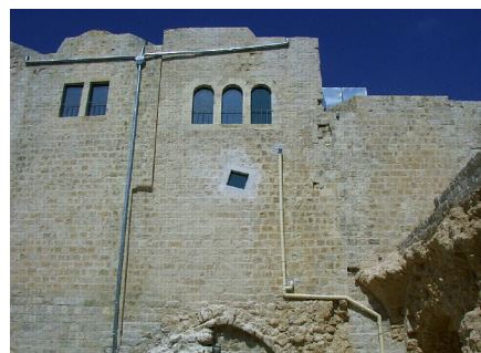
شكل رقم (128): صورة توضح تمديدات تصريف الأمطار، وإلى اليسار تمديدات الصرف الصحي لحمام مضاف. المصدر: الظاهر، 2006.
