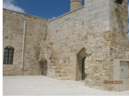
شكل رقم (85) : صورة توضح تمديدات تصريف المطر وتمديدات الكهرباء وأعمال الإنارة الخارجية في السبباط. المصدر: الباحث.
