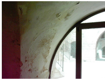
شكل رقم (131): صورة توضح الرطوبة نتيجة تسرب المياه إلى الداخل وإغلاق الأوابين. المصدر: الباحث.
