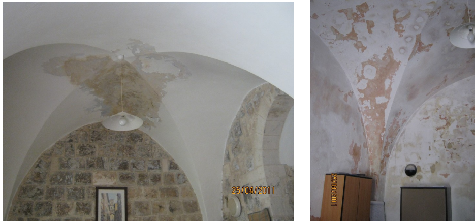
شكل رقم (89): صورة توضح الرطوبة نتيجة تسرب المياه إلى الداخل. المصدر: الباحث.
