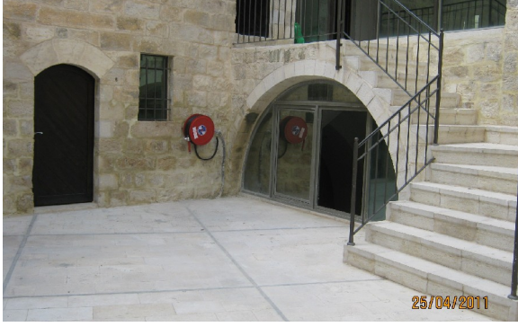
شكل رقم (115): صورة توضح تميز الحجر الحديث المضاف عن الحجر القديم وذلك للحفاظ على الأصالة العلمية في عملية الترميم. المصدر: الباحث.
