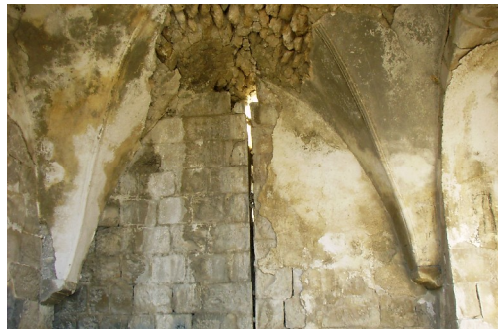
شكل رقم (117): صورة توضح كيفية معالجة تصدع في الواجهة الحجرية بتعبئة المونة داخله، يمين الشكل قبل المعالجة ويسار الشكل بعد عملية المعالجة. المصدر: الظاهر، 2006.
