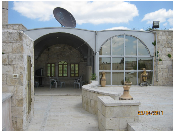
شكل رقم (82): صورة توضح الإضافات على المبنى عن طريق إعادة تسقيف المطبخ وعمل واجهات زجاج وألمنيوم. المصدر: الباحث.
