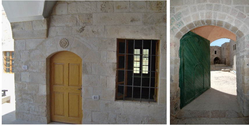
شكل رقم (79): صورة توضح تصميم الأبواب الخشبية وفي اليسار تظهر باب خشبي وزخارف فوق الباب وأيضاً طريقة معالجة السقف المتهدم عن طريق إضافة الحديد و(الفير غلاس). المصدر: أبو علي، 2006.
