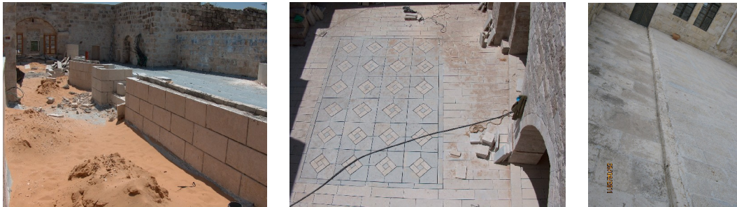
شكل رقم (77): صورة توضح عزل الأرضيات بلقائف الزفتة إلى اليسار قبل تبليطها ببلاط جديد إلى جانب البلاط القديم.
