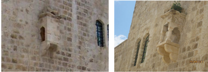
شكل رقم (94): صورة توضح أعمال الصيانة للمشربية في واجهة المدخل في قصر حسين عبد الهادي. المصدر: الباحث.
