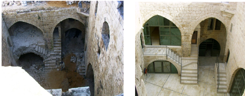
شكل رقم (126): صورة توضح الإضافات على واجهات الفناء الداخلي حيث تم ترميم الأدرج وإضافة حراسات حديدية و تم إضافة أبواب من الزجاج والألمنيوم والخشب والحديد وتظهر شكل البلاط الجديد في الفناء. المصدر: الظاهر، 2006.
