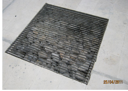
شكل رقم (130) : صورة توضح تمديدات الصرف وكيفية معالجتها في الفناء والحمام المضاف. المصدر: الباحث.
