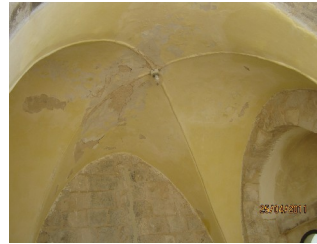
شكل رقم (131): صورة توضح الرطوبة نتيجة تسرب المياه إلى الداخل وإغلاق الأوابين. المصدر: الباحث.
