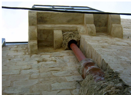
شكل رقم (128): صورة توضح تمديدات تصريف الأمطار، وإلى اليسار تمديدات الصرف الصحي لحمام مضاف. المصدر: الظاهر، 2006.
