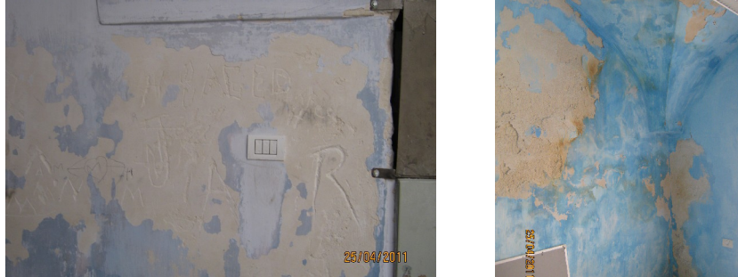
شكل رقم (91): صورة توضح انسلاخ الوجه الأخير للقصارة في إحدى الغرف وإلى اليسار تظهر الكتابة على الجدران عن طريق حفر القصارة في قصر عبد القادر عبد الهادي. المصدر: الباحث.
