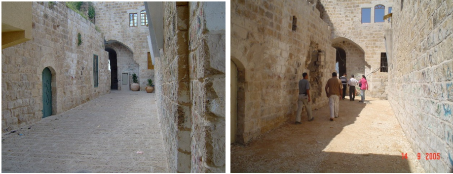
شكل رقم (72): صورة توضح تكملة الأحجار الناقصة، في اليمين قبل المعالجة وإلى اليسار بعد المعالجة. المصدر: أبو علي، 2006.
