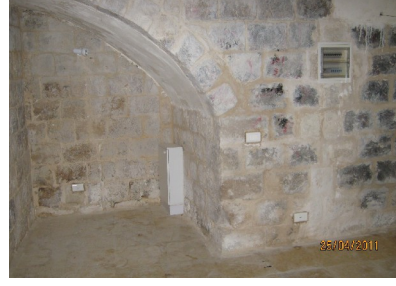
شكل رقم (129): صورة توضح تمديدات الكهرباء والميكانيك وكيفية معالجتها داخل الجدران وإلى اليسار شكل وطبيعة الحمام المضاف. المصدر: الباحث.
