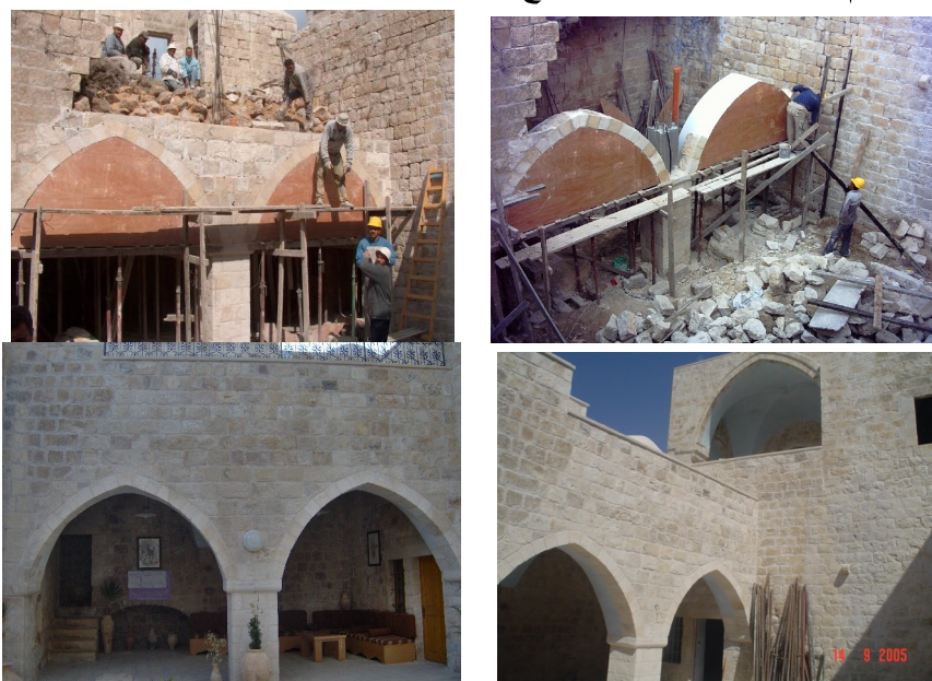
شكل رقم (74): صورة توضح تكملة الأقواس وتميز الحجر الحديث المضاف عن الحجر القديم وذلك للحفاظ على الأصالة العلمية في عملية الترميم. المصدر: أبو علي، 2006.
