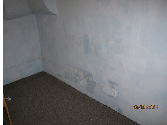
شكل رقم (86) : صورة توضح تمديدات الكهرباء وكيفية معالجتها. المصدر: الباحث.
