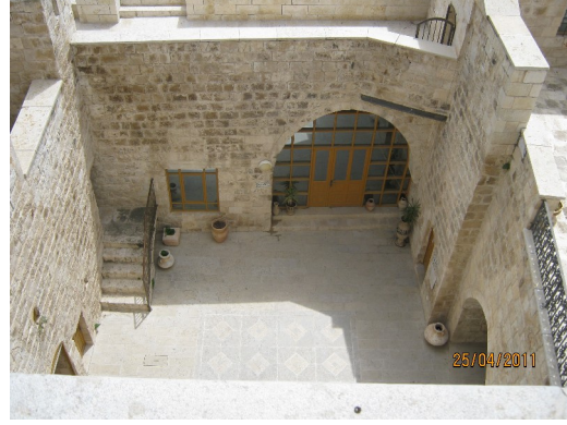
شكل رقم (80): صورة توضح الإضافات على واجهات الفناء الداخلي حيث تم ترميم الأدرج وإضافة حراسات حديدية وتم إضافة أبواب من الزجاج والخشب والحديد وتظهر شكل البلاط الجديد في الفناء. المصدر: الباحث.
