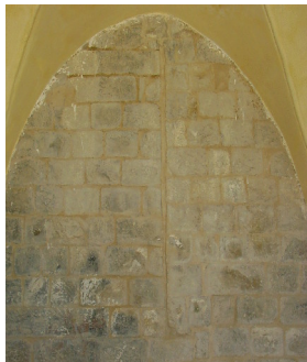
شكل رقم (117): صورة توضح كيفية معالجة تصدع في الواجهة الحجرية بتعبئة المونة داخله، يمين الشكل قبل المعالجة ويسار الشكل بعد عملية المعالجة. المصدر: الظاهر، 2006.
