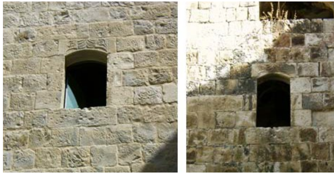
شكل رقم (120): صورة توضح إزالة الأعشاب من بين الحجر. المصدر: الظاهر، 2006.
