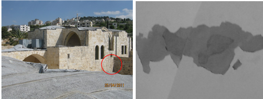
شكل رقم (133): صورة توضح انسلاخ الوجه الأخير للقصاره في إحدى الغرف وإلى اليسار ظهور بعض الإعتشاب الصغيرة على الواجهة الحجرية وتظهر شكل خزانات المياه على السطح. المصدر: الباحث.
