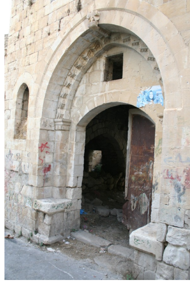
شكل رقم (16): صورة توضح واجهة المدخل وتظهر أقواس المدخل المدبب والموتور والنقش الحجري والباب الخشبي والخوذة والمكسلتين في قصر الكايد، سبسطية. المصدر: الباحث.
