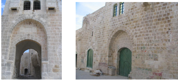
شكل رقم (14): صور توضح واجهة المدخل وتظهر فتحات الشبابيك المجوز وأقواس المدخل المدبب والموتور والنقش الحجري والمكسلتين في اليمين قصر حسين عبد الهادي، عرابة، وفي اليسار قصر الجبوسي، كور. المصدر: أبو علي، 2006.
