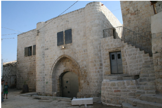
شكل رقم (15): صور توضح واجهة المدخل وتظهر فتحات الشبابيك المجوز وأقواس المدخل المدبب والموتور والنقش الحجري والباب الخشبي والخوذة والمكسلتين في اليمين قصر سحويل، عبوين، وفي اليسار قصر ابن سمحان، رأس كركر. المصدر: أرشيف رواق.
