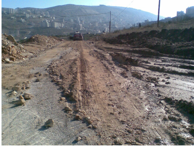
صورة (15): ترسيب لعمولة المياه الجارية من التربة والحصى على طريق معبد بسبب التغير المفاجئ في انحدار السطح، شرق بيت وزن.
