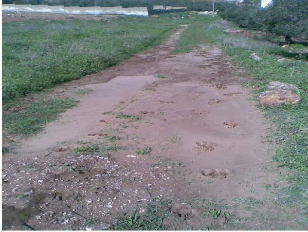
صورة (16): ترسيب لحمولة المياه الجارية من التربة الناعمة على طريق ترابي بسبب التغير المفاجئ في انحدار السطح، شرق قوصين.
