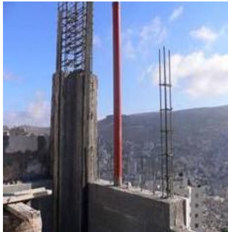
شكل (٦): تربيط الجدار الخارجي بالأعمدة الخارجية والتسليح حول فتحات النوافذ Jalal Al Dabbeek
