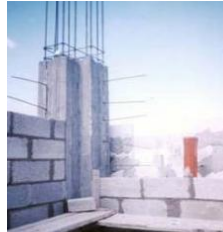
شكل (٦): تربيط الجدار الخارجي بالأعمدة الخارجية والتسليح حول فتحات النوافذ Jalal Al Dabbeek
